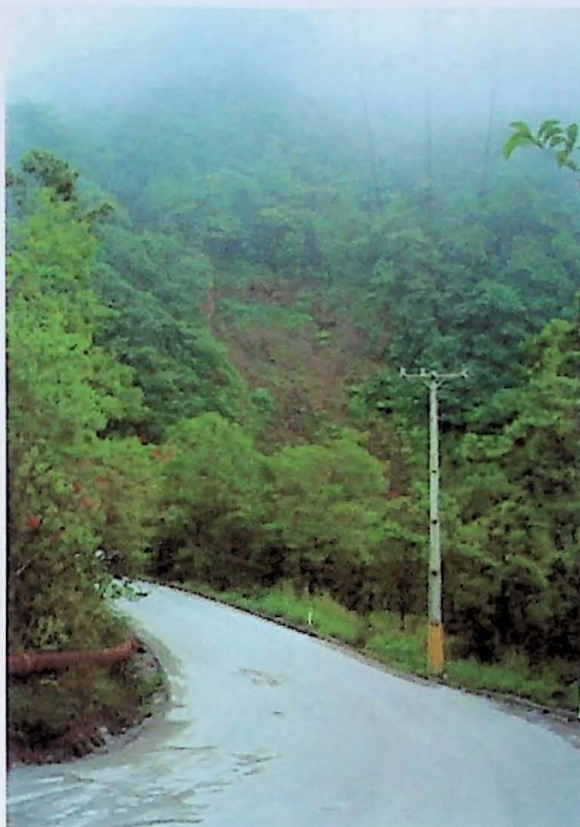
Foto 03 – Cicatriz de escorregamento translacional de grandes dimensões envolvendo parte do saprolito, localizado no fim do trecho 19 ESI.
