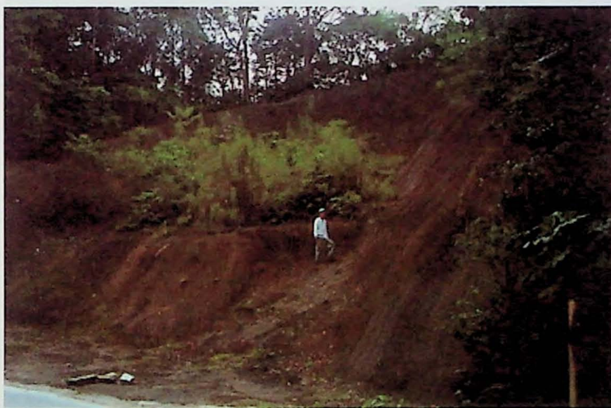
Foto 02 – Cicatriz de escorregamento translacional de cerca de 10m de altura e 12m de largura, protegida superficialmente com concreto projetado. A espessura de material escorregado é de aproximadamente 4m, envolvendo tanto o solo superficial como parte do saprolito. Localiza-se no fim do trecho 04 ESI.
