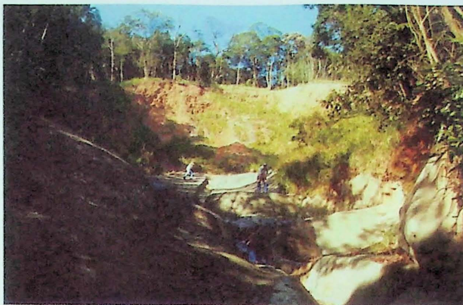
Foto 05 – Cicatriz de escorregamento rotacional localizado a montante do km 42+700 da pista norte da Via Anchieta (final do trecho 06 N). Notar o revestimento da cicatriz com calda de cimento.
