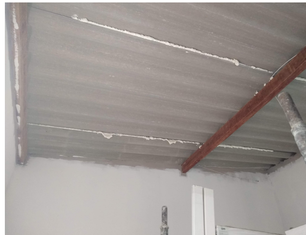
Figura 78. Espuma expansiva aplicada no vão das telhas.
