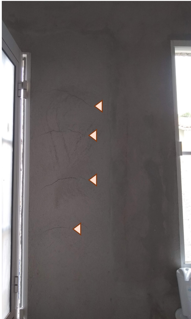
Figura 60. Fissuras por reação química da argamassa.
