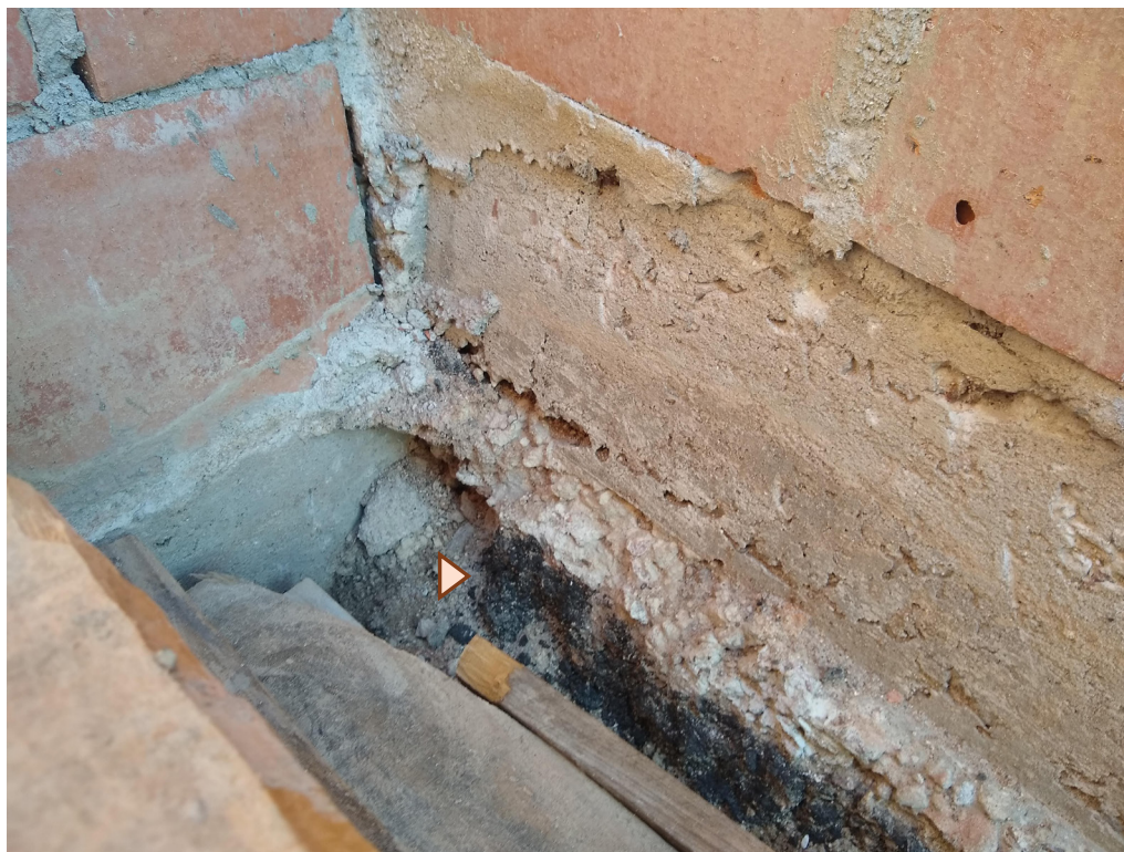
Figura 37. Asfalto embaixo da viga baldrame do muro.
