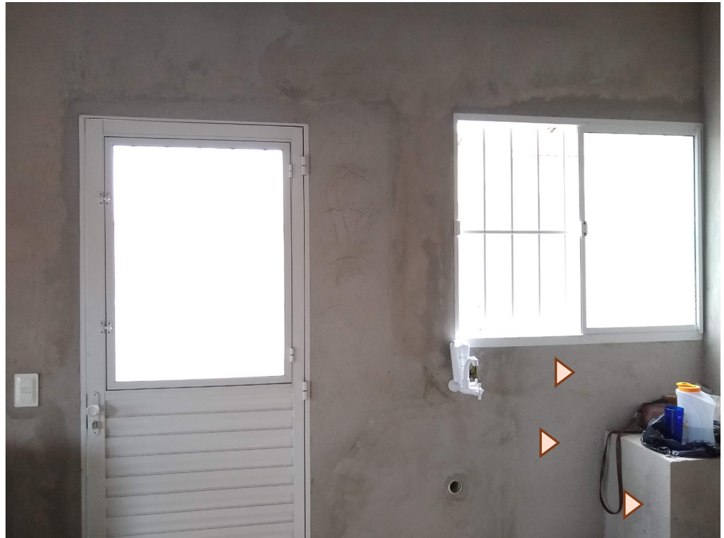
Figura 61. Fissuras no acabamento.
