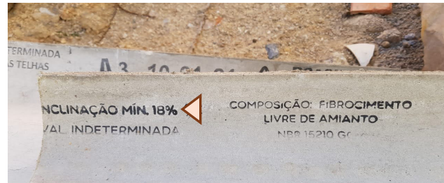
Figura 64. Telha com informações para instalação – inclinação.
