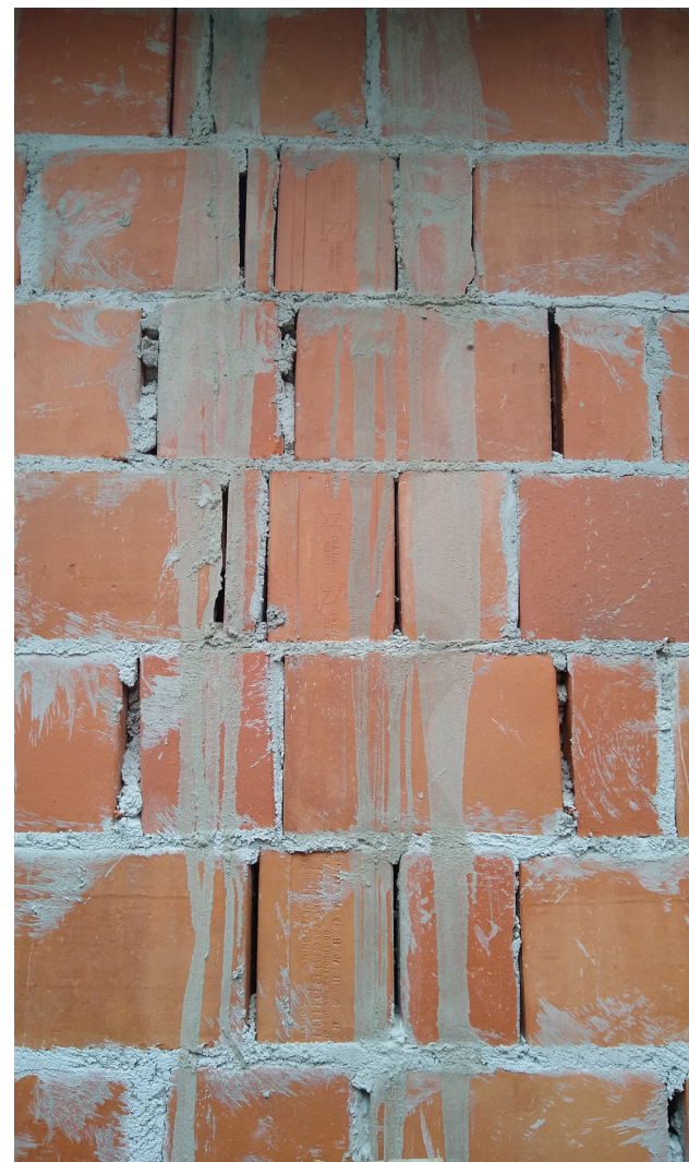
Figura 39. Falta de blocos de amarração, não uniformidade da argamassa de assentamento e falta de preenchimento das juntas verticais.
