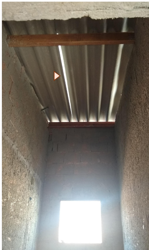
Figura 68. Claridade entre as telhas causada pelo embarrigamento – Banheiro.
