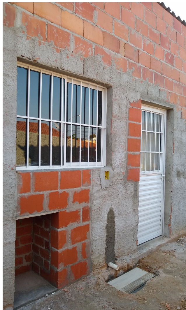
Figura 59. Esquadrias instaladas, fechamento dos vãos e caixa de passagem de esgoto.
