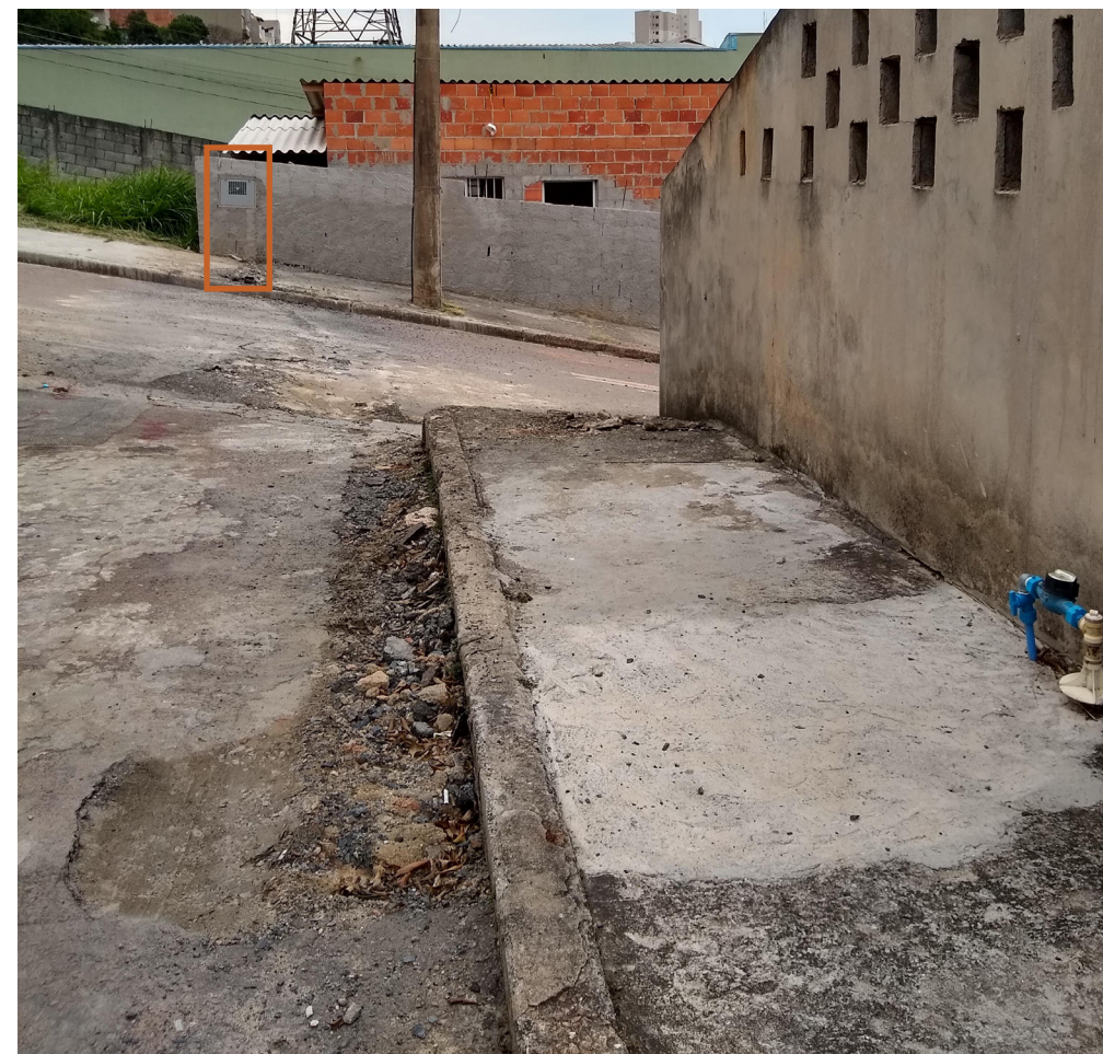
Figura 48. Ligação com o sistema público de fornecimento de água.
