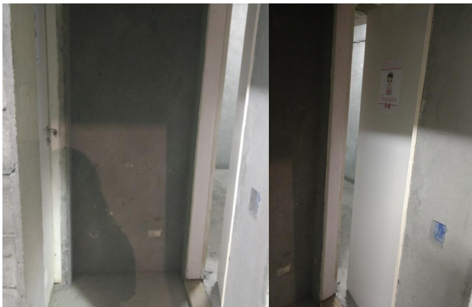
Figura 7 – Corredor banheiros administrativo
