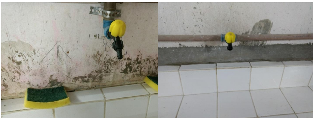
Figura 27 – Lavatório antes e após
