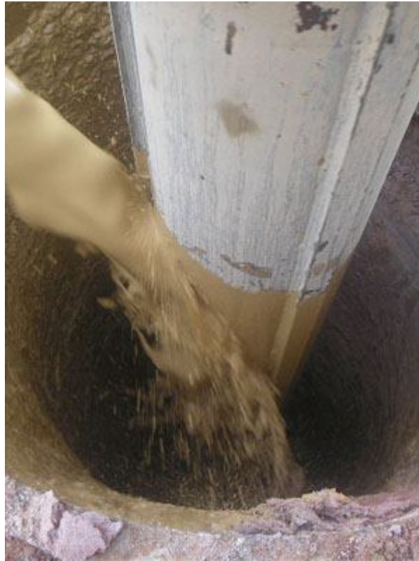
Figura 8: Lama bentonítica sendo adicionada a um poço.
