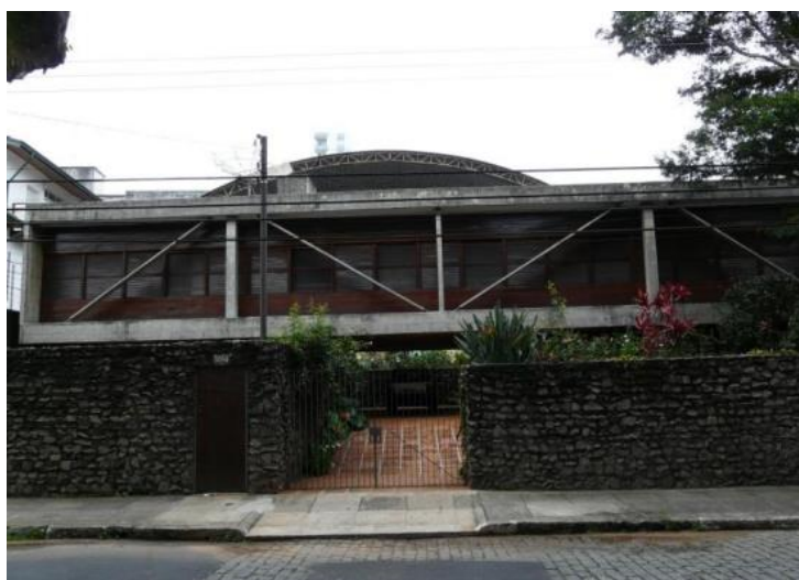
Figura 03: Foto da fachada da Casa Mendes André. Fonte: PETROSINO, 2009.
