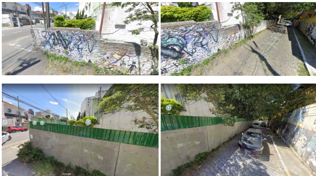
Figuras 04, 05, 06 e 07. Fotos do muro antes e depois da demolição. Fonte: Google Street View, 2022.
