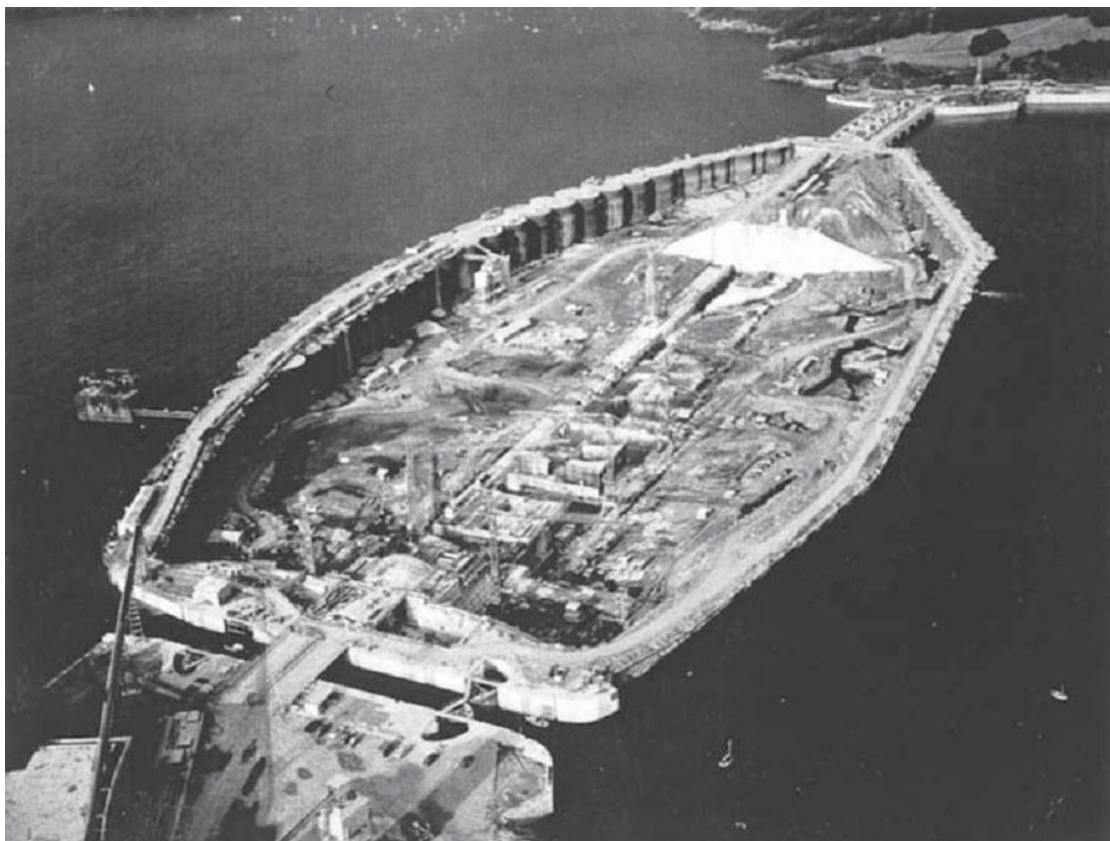
Figura 27: Construção da usina de La Rance com utilização de ensecadeiras (Eletricit  de France).
