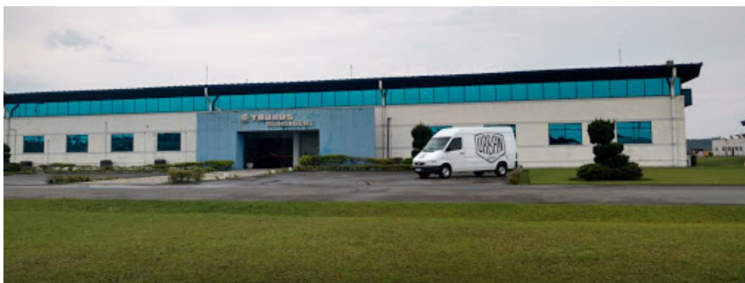
Figura 10 - Vista Frontal da Fábrica em Mandirituba
