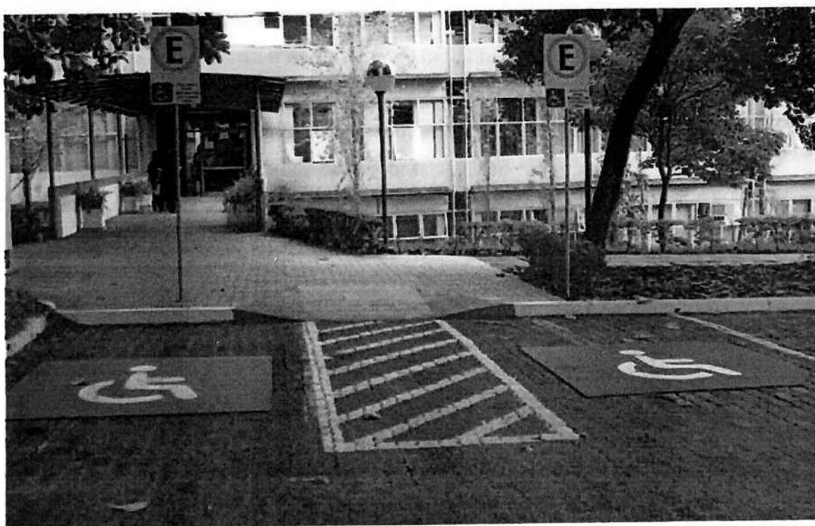
Fig. 2 – Rebaixamento de guia para acesso à edificação e implantação de calçada com piso intertravado, facilitando o acesso com cadeira de rodas. IF/USP
