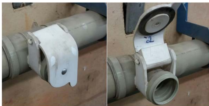
Figura 41 – Detalhe do ponto de conexão com o duto principal.
