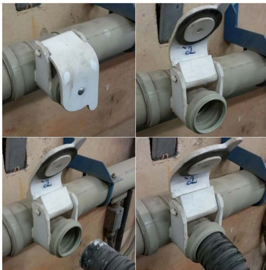
Figura 39 – Sequência de Conexão da Mangueira do Coletor.
