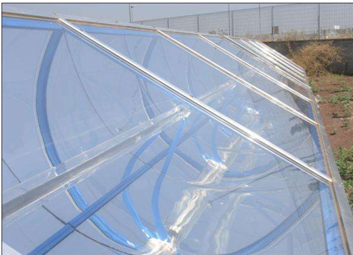
Figura 5 - Concentrador parabólico linear (Fonte: SolarPACES)
