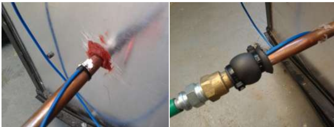
Figura 38 - A esquerda sensor do termopar revestido com pasta térmica, a direita o conjunto coberto por espuma elastomérica
