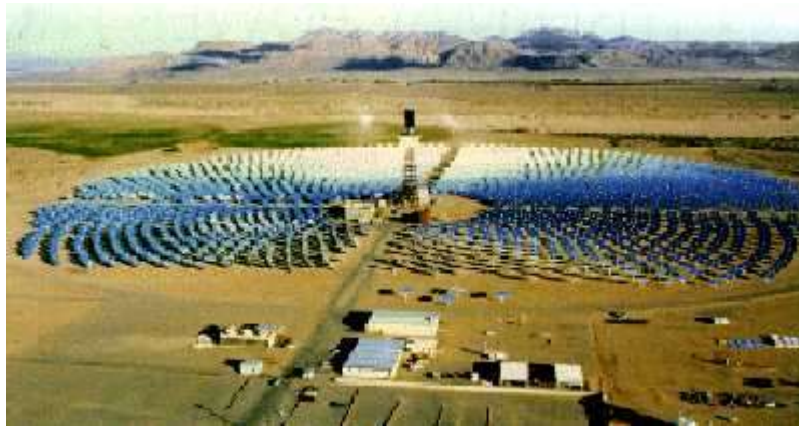
Figura 8 - Coletor com receptor central (Fonte: SolarPACES)
