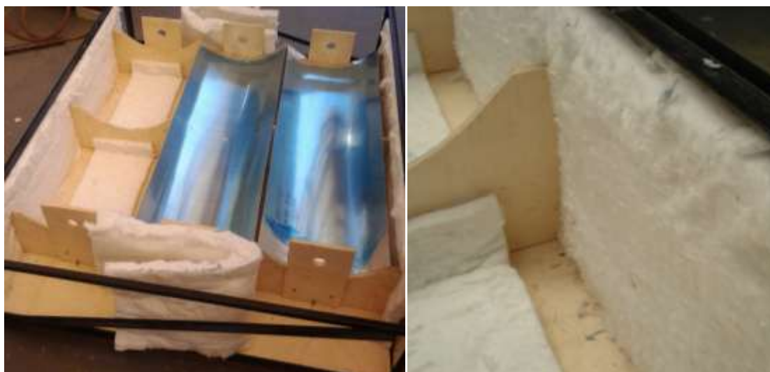
Figura 34 - Isolamento térmico com lã de rocha
