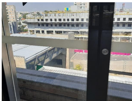
Figura 40 - Vista da parte externa da estação Vila Prudente monotrilho Linha 15 Prata – ao fundo, novas edificações ( foto de Vanessa Alessandra de Souza, julho de 2022).
