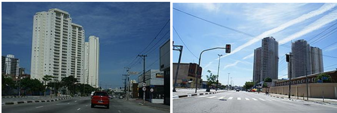
Figuras 5 e 6 . Fotografias extraídas no início dos anos 2000, no atual trecho correspondente à área de influência da estação Oratório Linha 15-Prata. Ademais, demonstra o processo de verticalização no trecho face à “ideia” da futura implantação do metrô e do monotrilho a expansão imobiliária é evidente. Fonte: https://pt.wikipedia.org/wiki/Avenida_Professor_Luis_In%C3%A1cio_de_Anhaia_Melo
