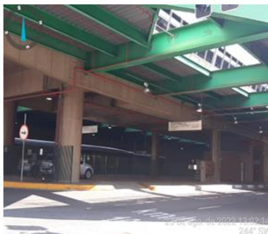
Figura 42 - Novo Terminal Vila Prudente – acesso ao metrô e trem. (foto de Vanessa Alessandra de Souza, agosto de 2022)
