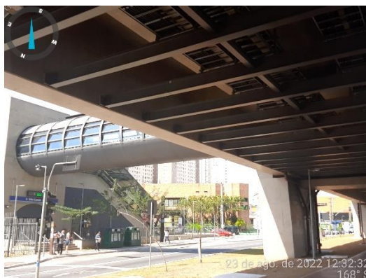
Figura 34 - Vista de fora da estação do monotrilho Linha 15-Prata, São Lucas. (foto de Vanessa Alessandra de Souza, agosto de 2022).
