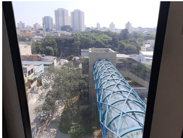
Figura 36 - Vista da saída da estação Oratório ( foto de Vanessa Alessandra de Souza, julho de 2022)
