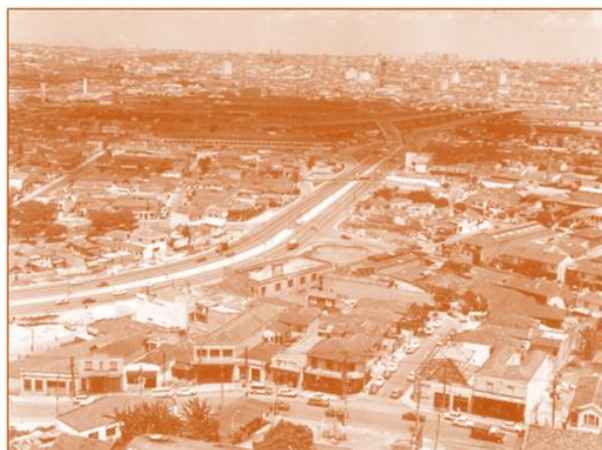
Figura 9 - Visão aérea do trecho correspondente Vila Prudente ( área mais clara) e Oratório e São Lucas (áreas mais sombreadas). Verificam-se a baixa verticalização, casas modestas e galpões industriais. Foto de 28 de fevereiro de 1977. Fonte: (BERGES, 2013, p. 190)
