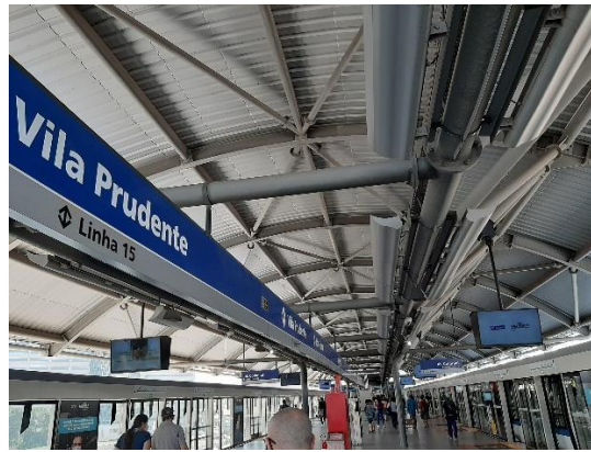
Figura 38- Vista da estação do monotrilho Linha 15 Prata. (foto de Vanessa Alessandra de Souza)
