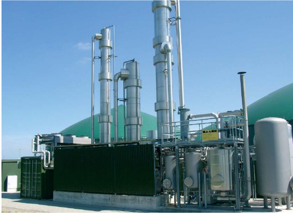
Figura 3.2 Conjunto de tratamento de Biogás com Genosorb.
