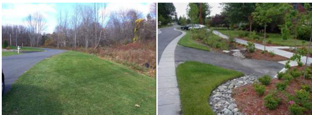
Figura 21: Exemplo de Faixa Filtrante e de Vala Gramada.
