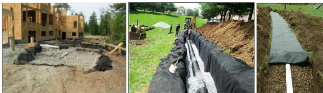
Figura 23: Exemplos de Poço de Infiltração e de Trincheiras de Infiltração.
