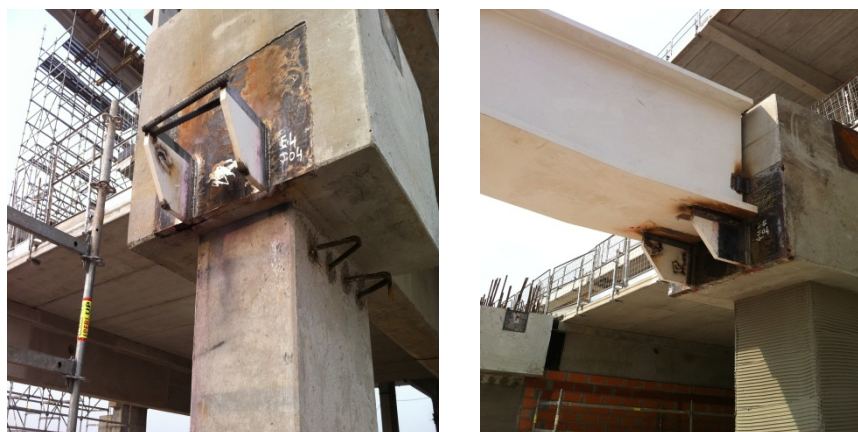
Figura 10. – Exemplo de inserte metálico para posterior fixação de peça metálica
