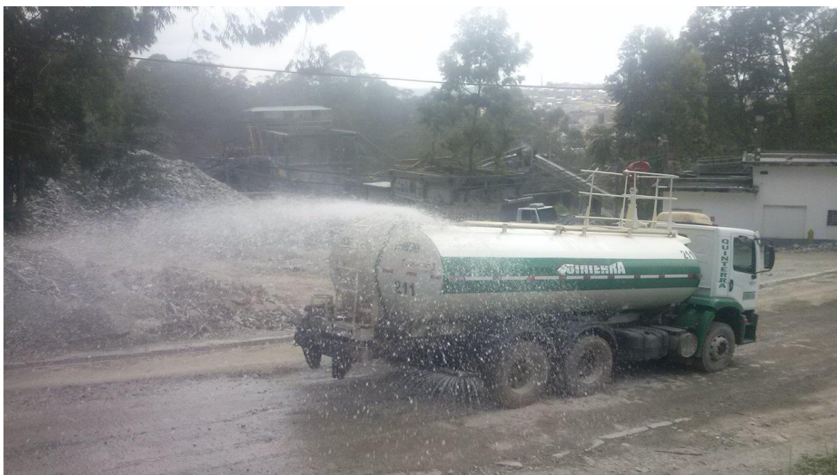
Figura 33. Umectação das áreas de tráfego dos caminhões.
