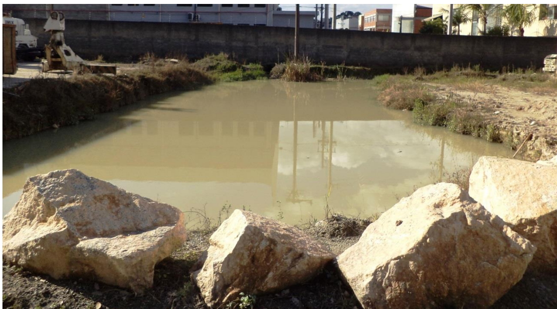
Figura 23. Bacia de contenção/decantação.
