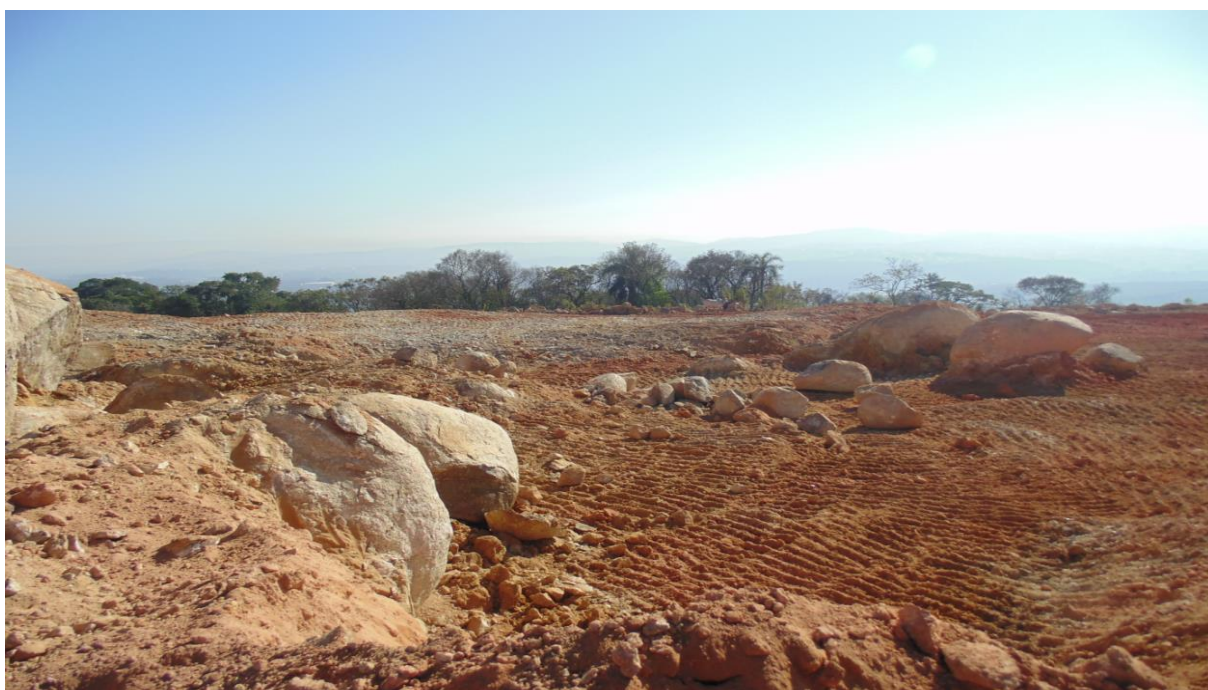
Figura 5. Decapeamento do solo para produção de agregado.
