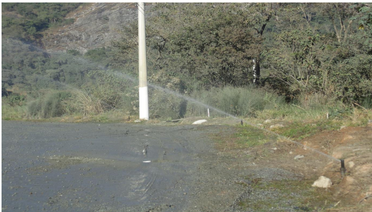
Figura 34. Umectação das vias de acesso através de bicos aspersores 1.
