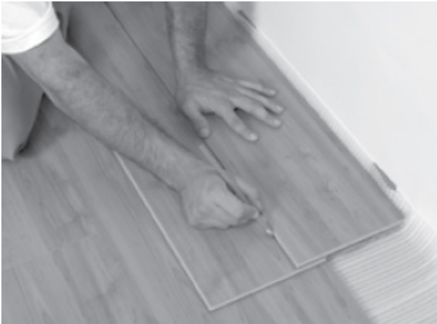
Figura 31: Piso laminado sobre manta acústica.
