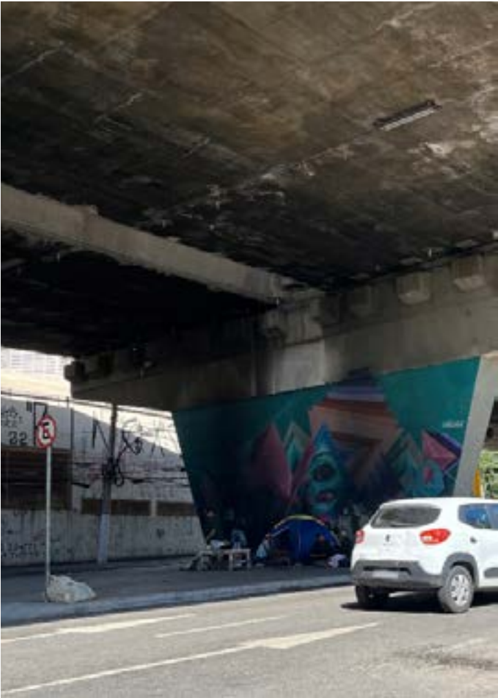
◄ Figura 6: População em situação de rua ocupando o espaço do adjacente à área de convivência do Viaduto Antártica. (Fonte: Arquivo do autor, 2024)
