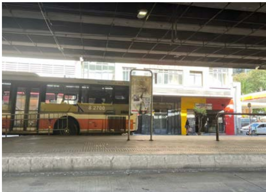
◀ Figura 22. Exemplo do mobiliário urbano mais frequente na marquise do Elevado: gradis e encosto e sinalização para ponto de ônibus. (Fonte: Autor, 2024).
