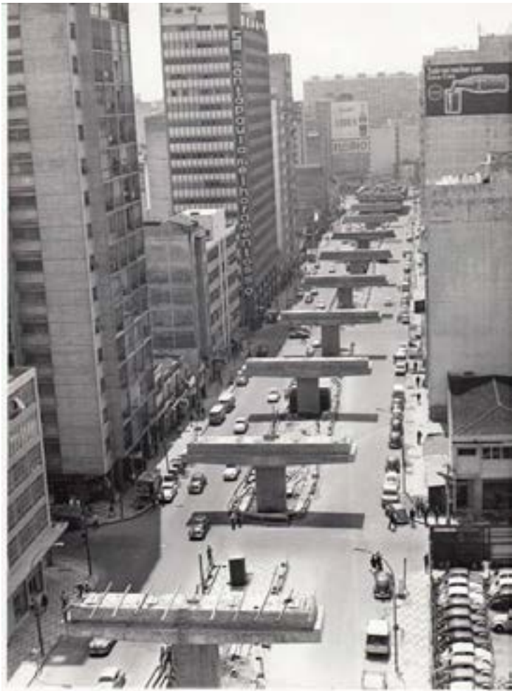
◄ Figura 7. Construção dos pilares do Elevado Pres. João Goulart no trecho da Rua Amaral Gurgel, final dos anos 60 (Fonte: São Paulo em Fotos, 2024).
