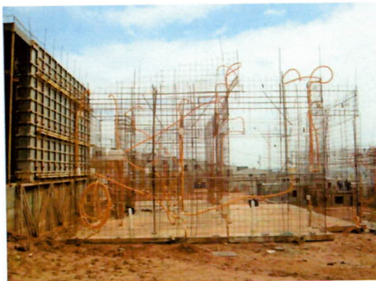
Figura 10: Fixação das instalações embutidas nas telas Fonte: Homex Construtora
