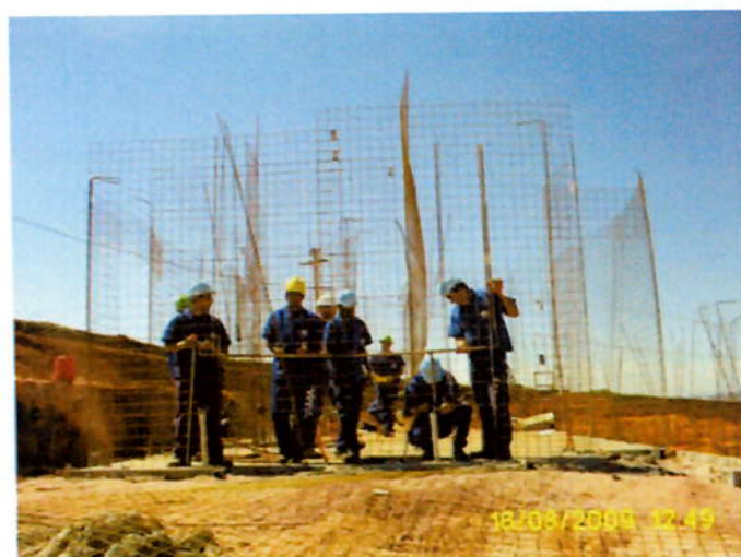
Figura 09: Colocação das telas e reforços Fonte: Homex Construtora
