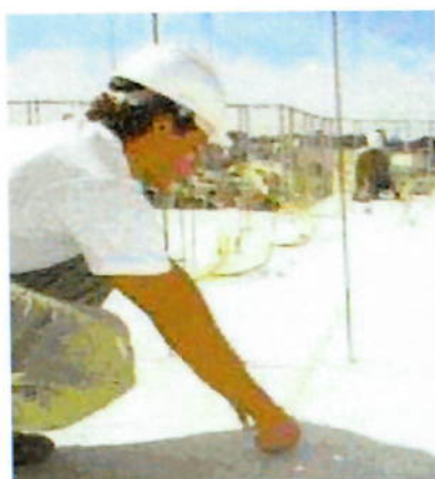
Figura 01: Conferência do eixo de referência da marcação Fonte: Construtora Tenda
