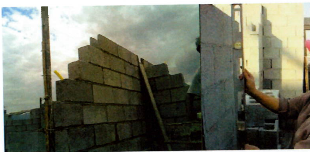
Figura 07: Procedimentos para garantir nível e prumo da segunda elevação Fonte: Concreteshow 2008
