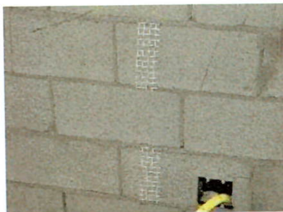
Figura 05: Tela eletrosoldada para amarração de paredes Fonte: Construtora Tenda
