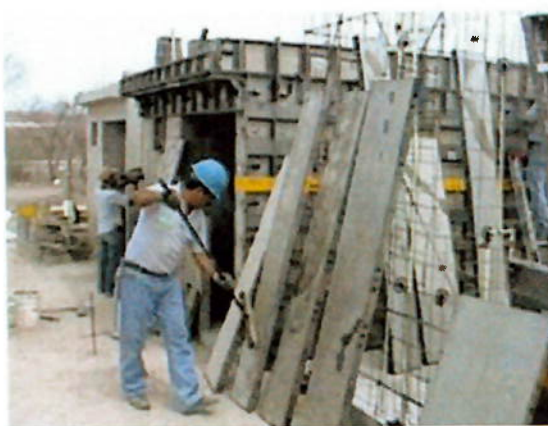
Figura 13: Aplicação de desmoldante nas fôrmas Fonte: Homex Construtora
