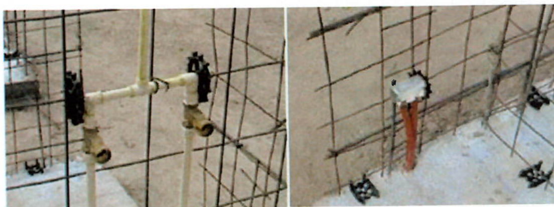
Figura 11: Colocação de espaçadores próximos às instalações Fonte: Homex Construtora
