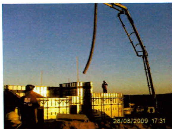
Figura 17: Concretagem das paredes e laje Fonte: Homex Construtora
