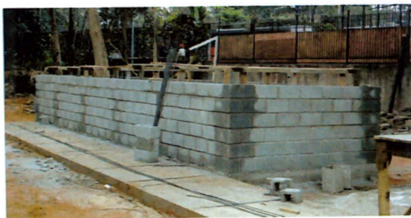
Figura 04: Assentamento da primeira elevação Fonte: DT Engenharia
