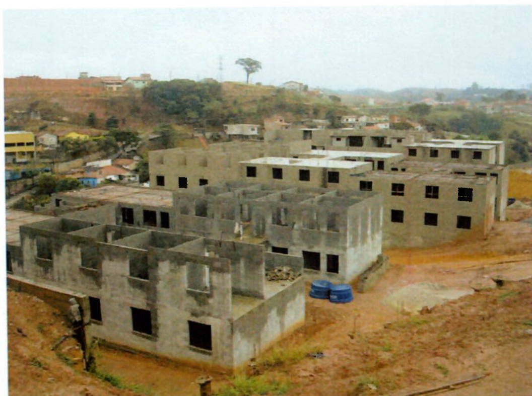
Figura 25: Etapa 1 – Edifícios em Alvenaria Estrutural (julho/2010) Fonte: Dados internos do projeto
