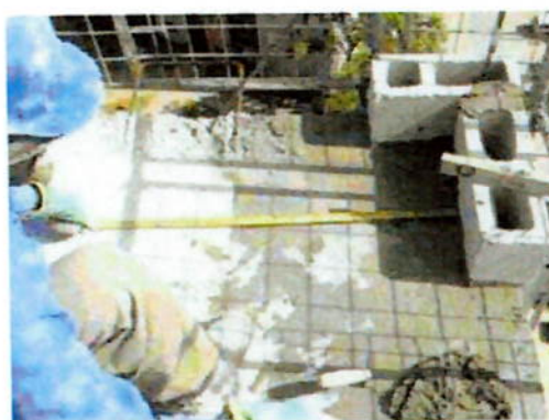
Figura 02: Assentamento dos primeiros blocos Fonte: Construtora Tenda
