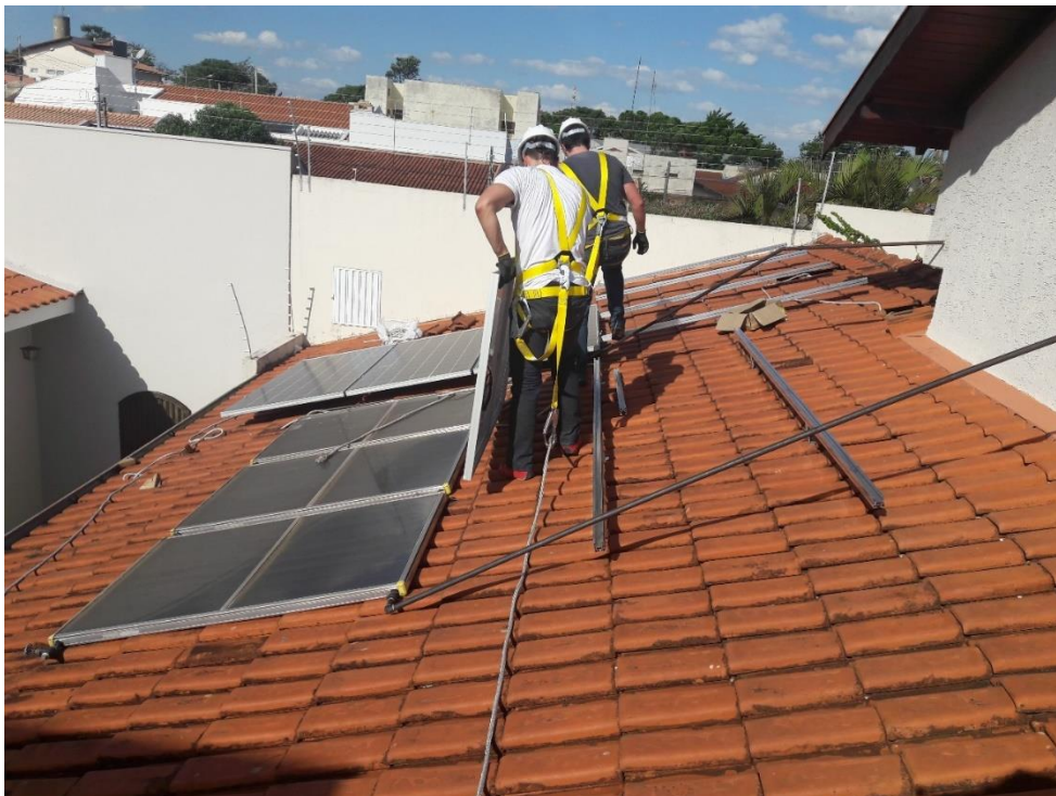
Figura 20: içamento dos módulos fotovoltaicos.
