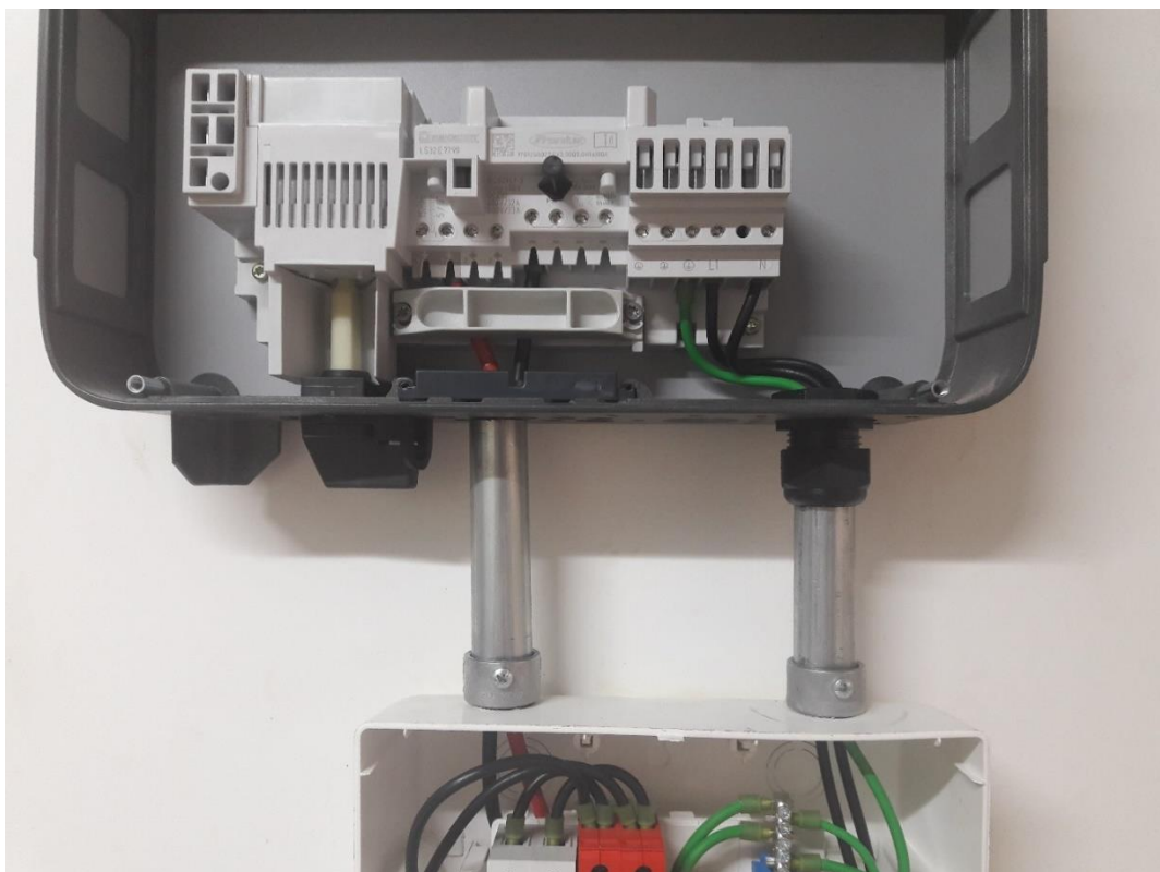
Figura 26: detalhamento das ligações de entrada e saída do inversor.
