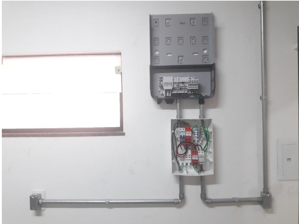
Figura 25: montagem do sistema de condicionamento de potência e proteção.
