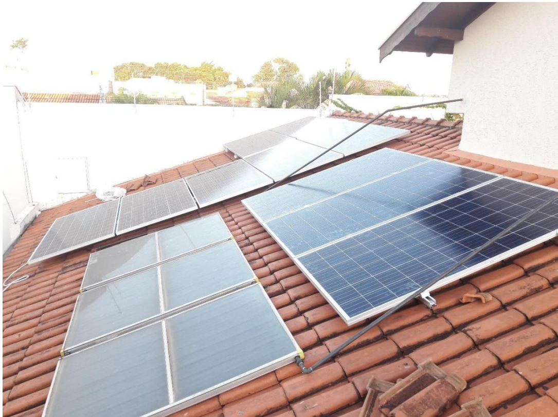
Figura 22: arranjo fotovoltaico instalado.
