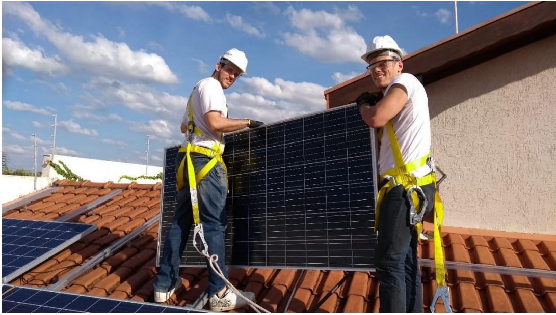
Figura 21: içamento dos módulos fotovoltaicos.
