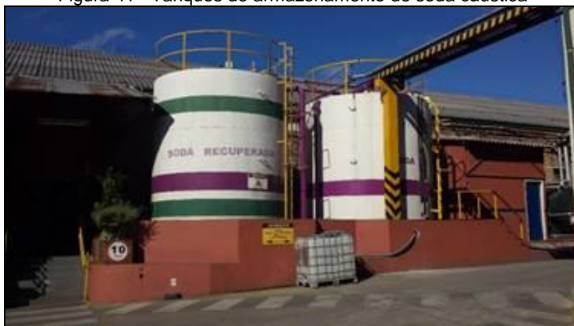
Figura 41 - Tanques de armazenamento de soda cáustica
