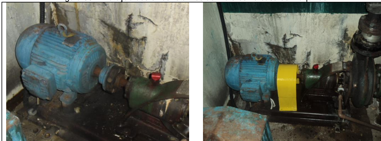
Figura 59 - Proteção dos eixos rotativos de motores na casa de máquinas
