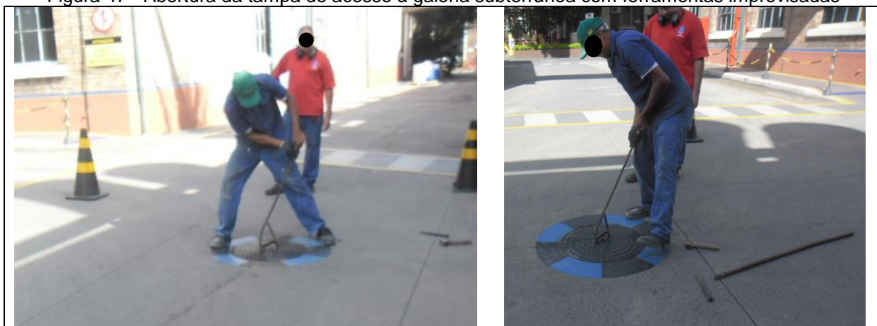
Figura 47 - Abertura da tampa de acesso à galeria subterrânea com ferramentas improvisadas
