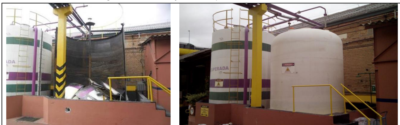
Figura 62 - Substituição do tanque de soda cáustica
