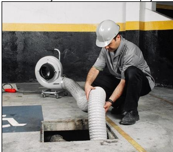
Figura 13 - Ventilação mecânica em um espaço confinado
