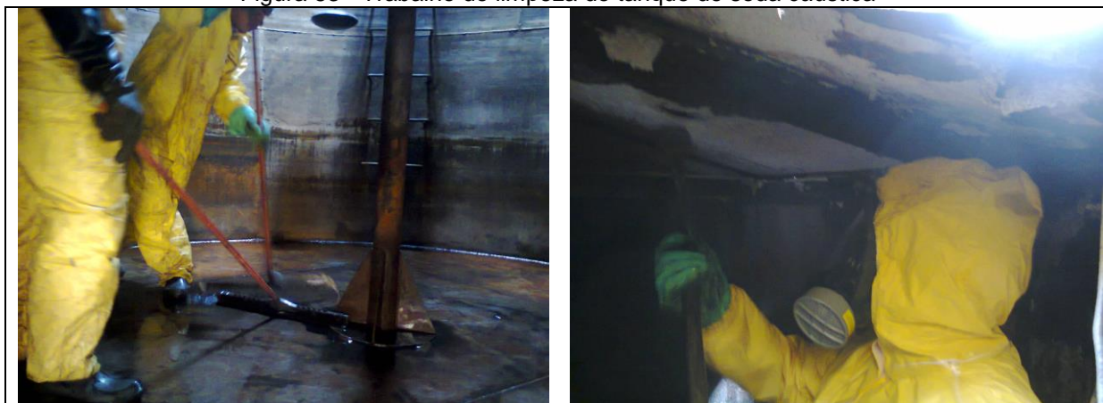
Figura 53 - Trabalho de limpeza do tanque de soda cáustica
