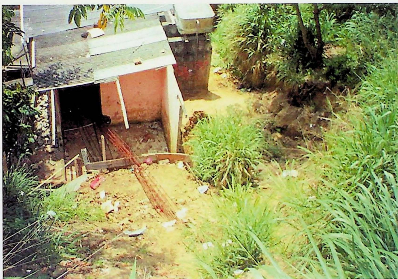
Foto 18 - Escorregamento de aterro lançado
