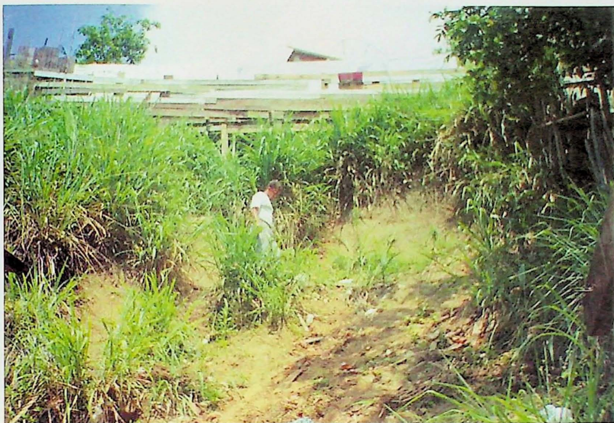
Foto 17 - Escorregamento de aterro lançado
