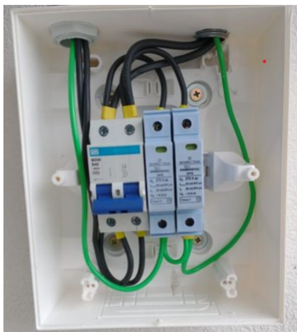
Figura 29 – Local de instalação do circuito de proteção do inversor
