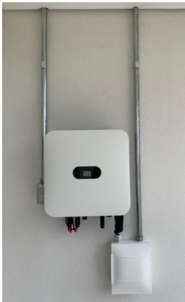
Figura 28 – Local de instalação do inversor
