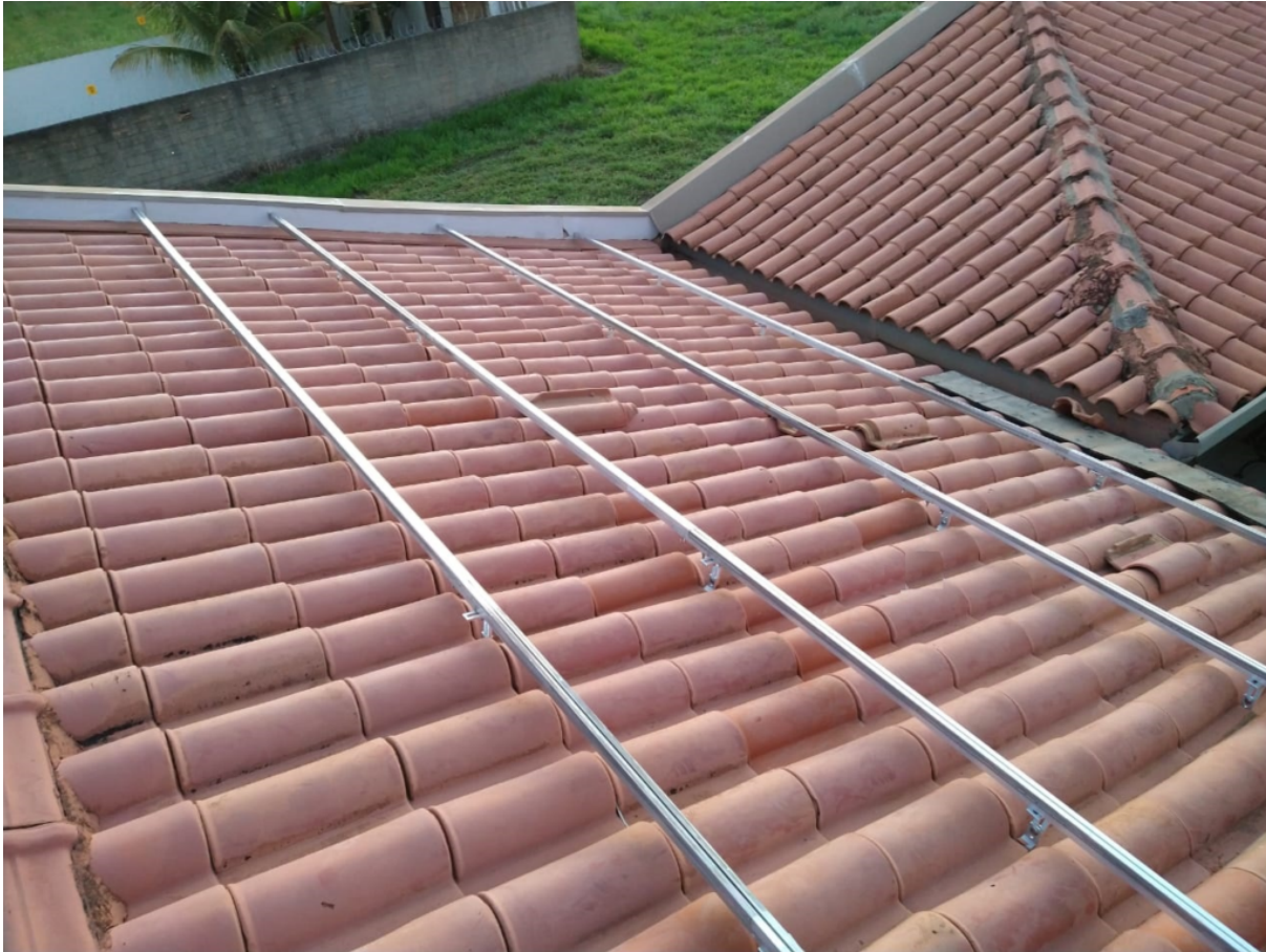
Figura 13 – Exemplo de estrutura de fixação. Fonte: (MASTER, 2021)
