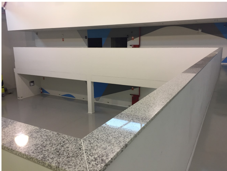
(a) Galpão - Destaque para parapeito do mezanino
