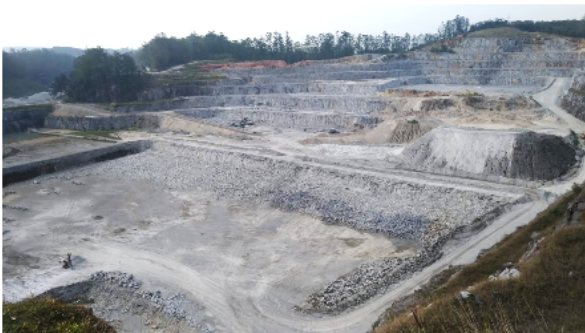
Foto 02: Registro fotográfico da cava da pedreira e suas bancadas. Fonte: a autora em 24 de Setembro de 2019.
