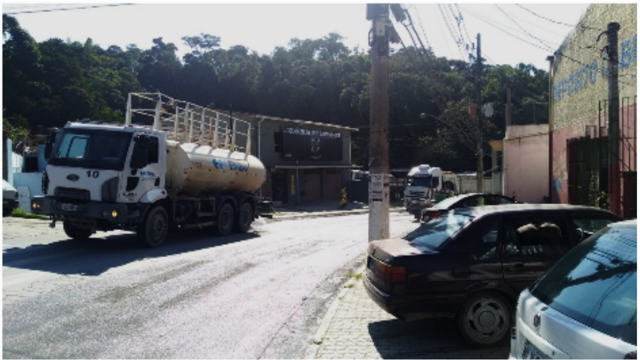
Foto 09: Registro fotográfico do caminhão pipa realizando a umidificação de vias a fim de conter a poeira gerada pela atividade. Fonte: a autora em 17 de Junho de 2020.
