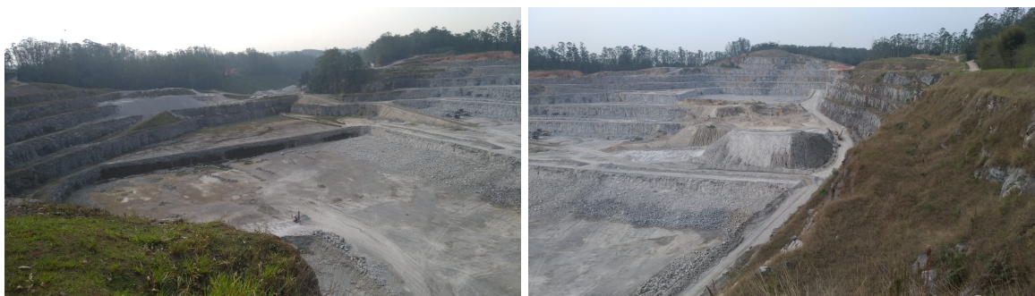
Foto 03 e 04: Registros fotográficos da cava da pedreira e suas bancadas. Fonte: a autora em 24 de Setembro de 2019.
