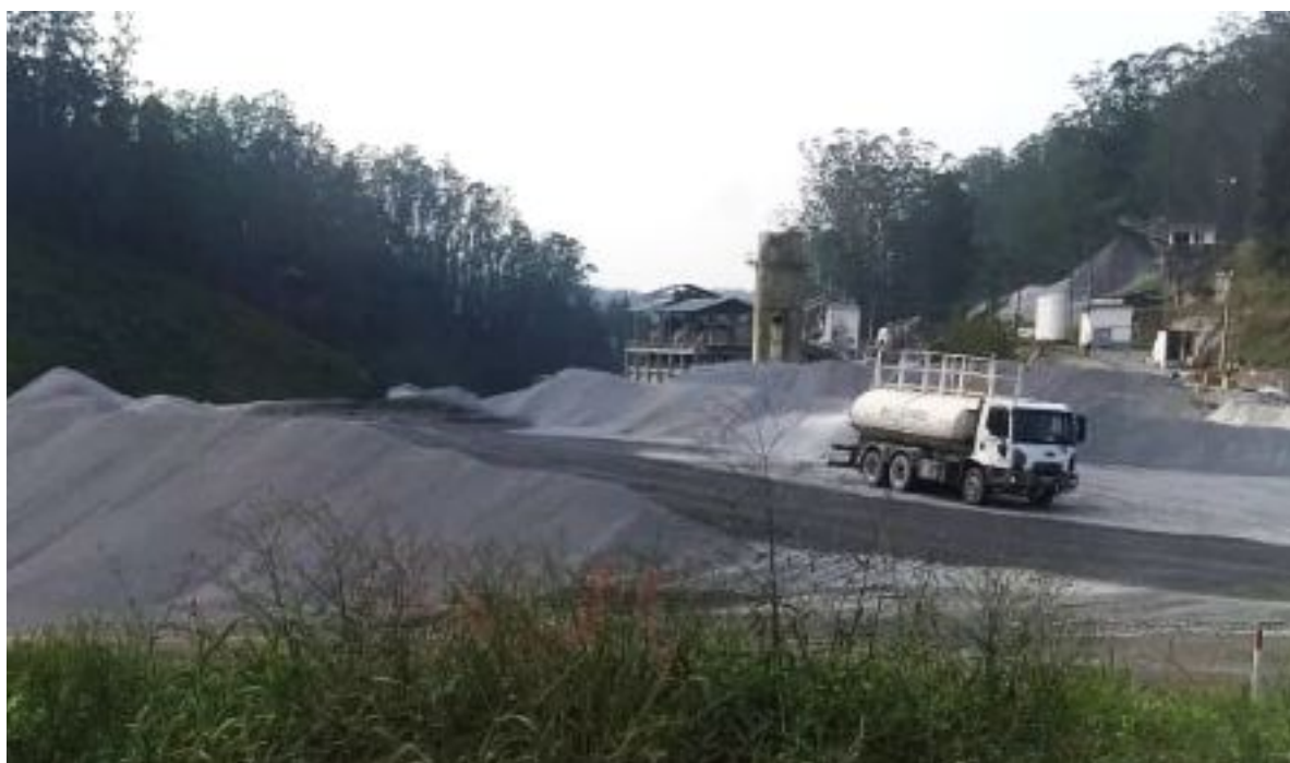
Foto 01: Registro fotográfico do caminhão pipa umedecendo as vias a fim de evitar que a poeira se alastre. Fonte: a autora em 24 de Setembro de 2019.
