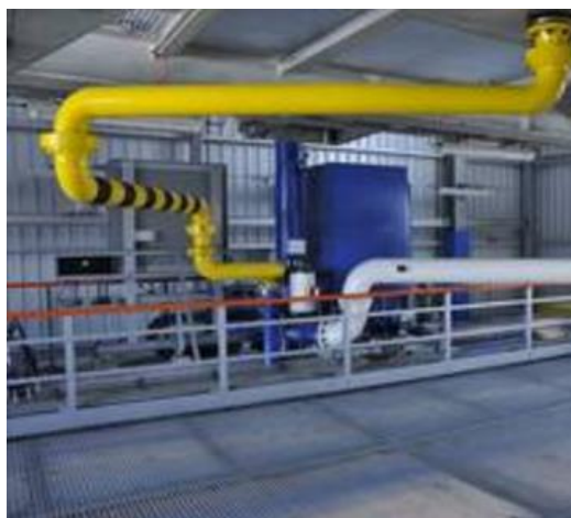
Figura 25: Tubulação Articulada que Abastece o Braço [18]
