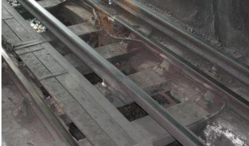
Figura 9 - Foto ilustrativa do 3º e 4º trilhos, e trilhos de rolamento na Estação White City em Londres.
