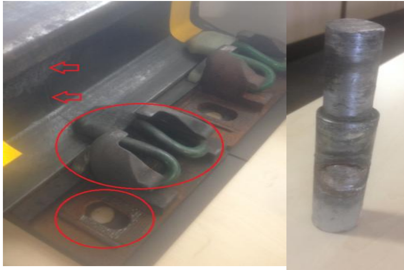
Figura 6 – Trinca do Trilho e Sinais de Corrente de Fuga. Fonte: O próprio autor, 2016.
