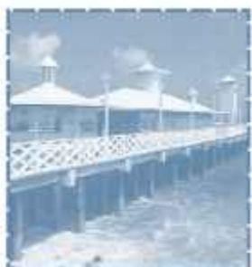
PONTE DOS INGLESES
