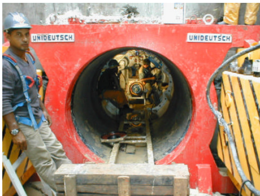
Figura 2: Microtuneladora
