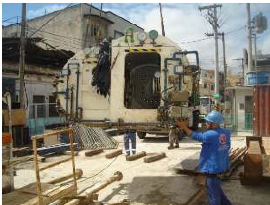
Figura 32: Içamento da câmara hiperbárica
