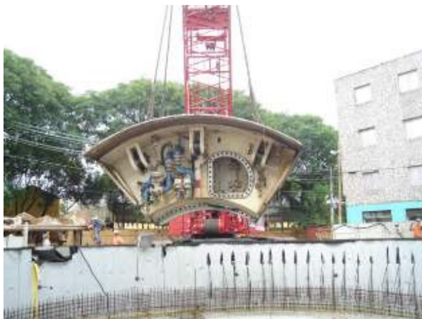
Figura 34: Içamento do primeiro quarto da parte frontal do “shield”
