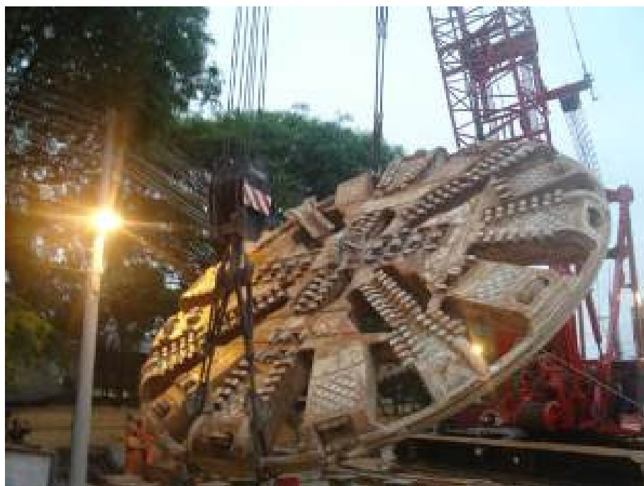
Figura 27: Posicionamento da roda de corte no canteiro do poço João Teodoro
