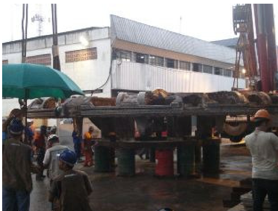
Figura 28: Posicionamento da roda de corte no canteiro do poço João Teodoro
