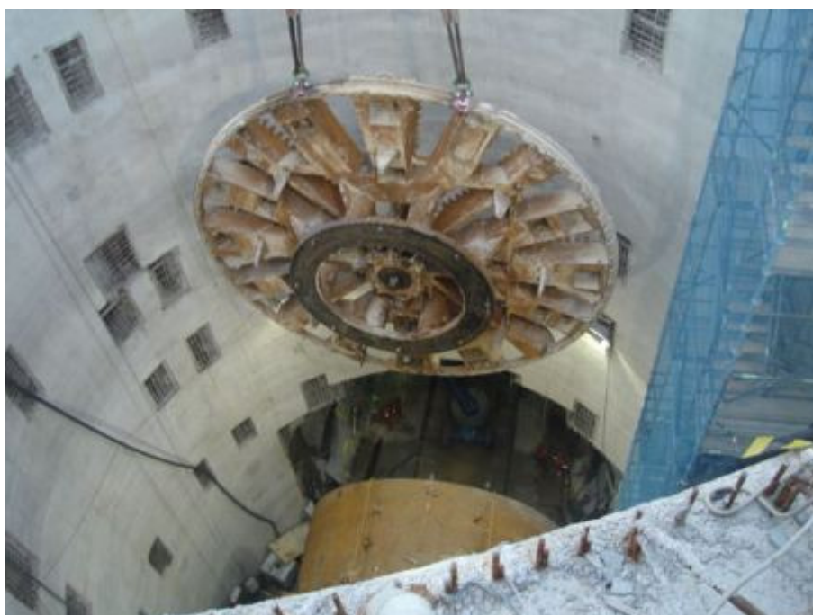
Figura 26: Içamento da roda de corte
