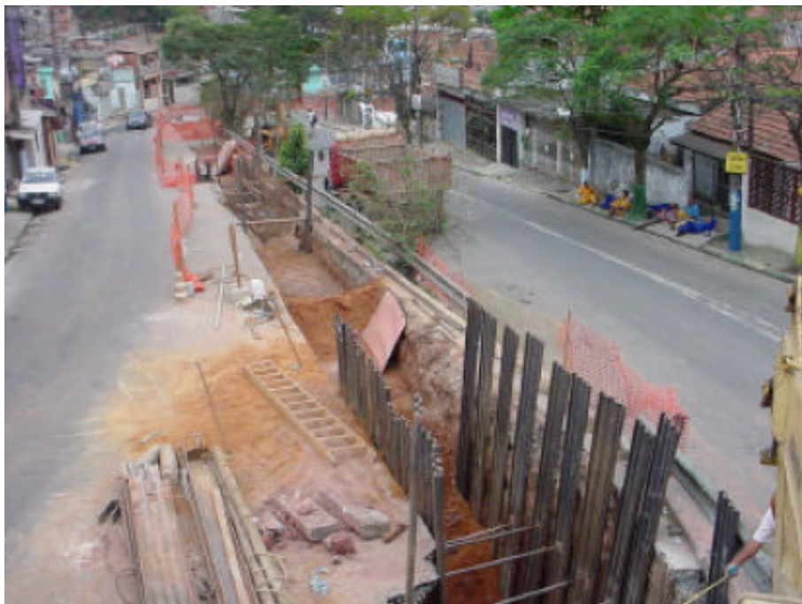
Figura 1: Método da Vala a Céu Aberto com escoramento metálico
