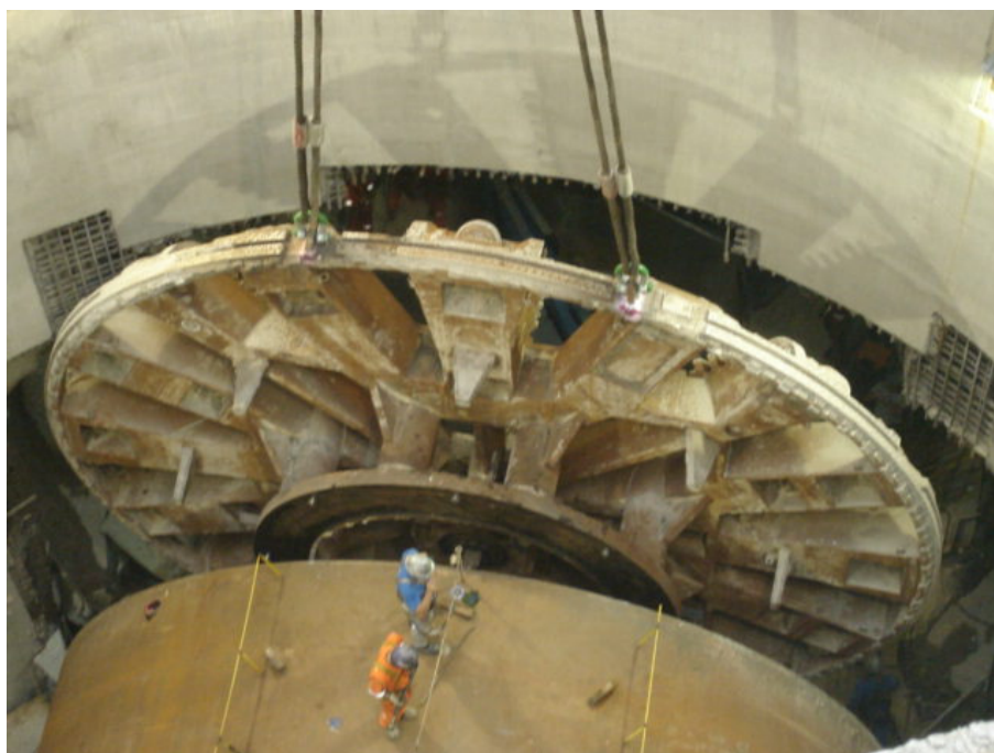
Figura 25: Içamento da roda de corte
