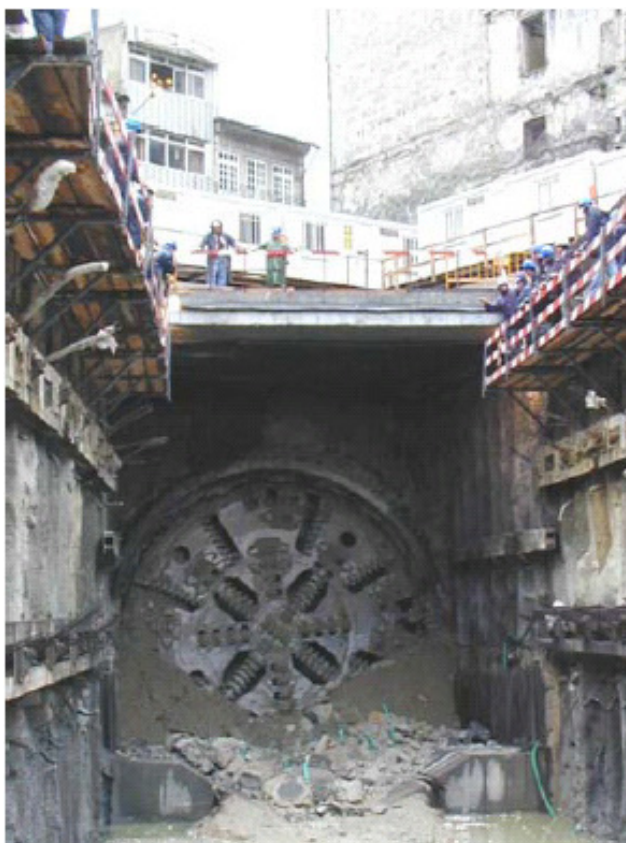
Figura 18: TBM tipo EPB utilizado em Porto
