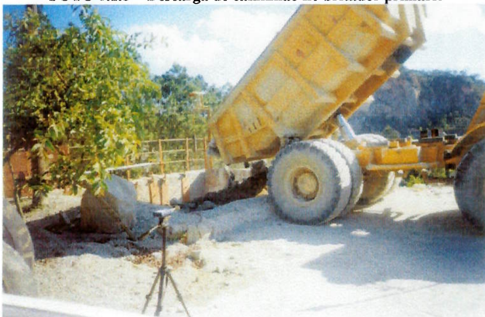
FOTO 8.1.5 – Descarga de caminhão no britador primário
