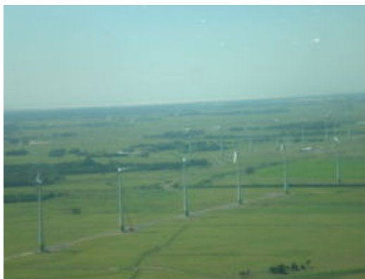
Figura 3.1 - Parque Eólico de Osório-RS. Fonte: Wikipedia [14] .
