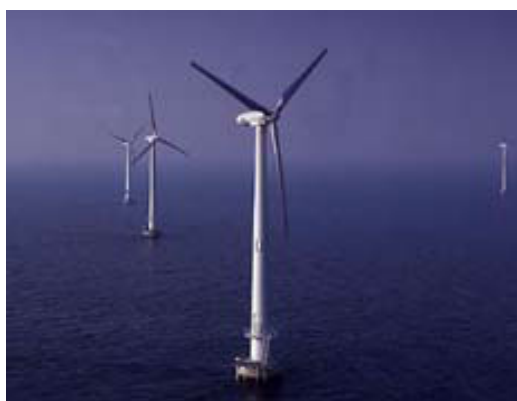
Figura 2.3 - Turbinas Eólicas instaladas Off-Shore (Litoral da Dinamarca) [10] .
