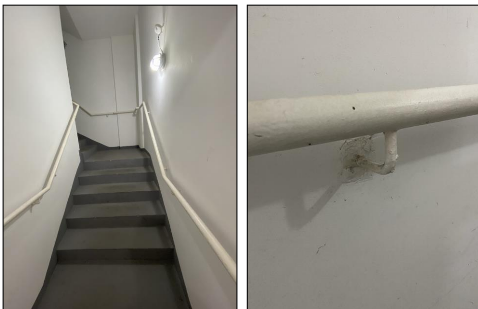
Figura 12 – Detalhe dos corrimãos das escadas de emergência
