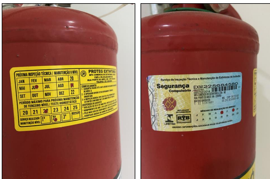
Figura 21 – Detalhe dos selos e validade de extintores inspecionados
