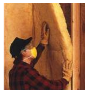
Figura 3: Aplicação de isolamento batt.
