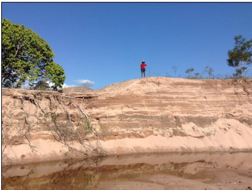
Foto 18 Área de ruptura com aproximadamente 10 metros. Área acima está a superfícies planas dos despejos. Esses paredões são formados nas bordas desses grandes materiais retirados do leito.
