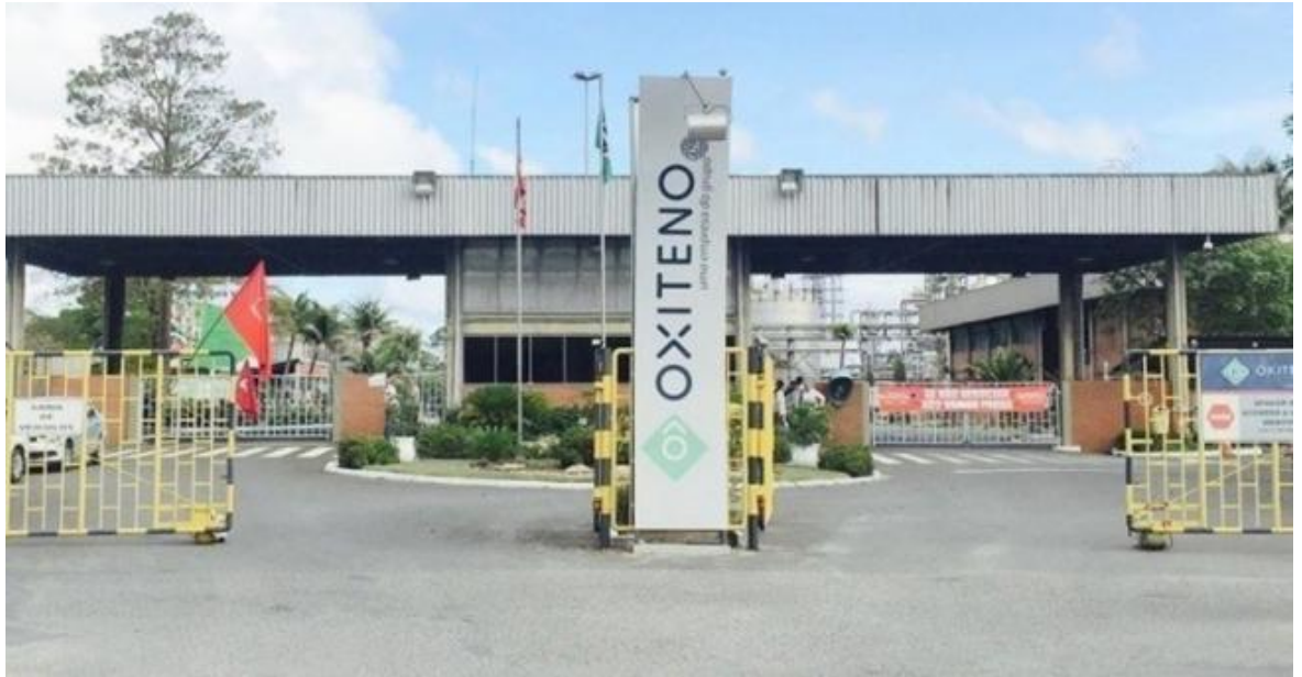
Figura 1 – Fachada da planta da Oxiteno de Mauá-SP
