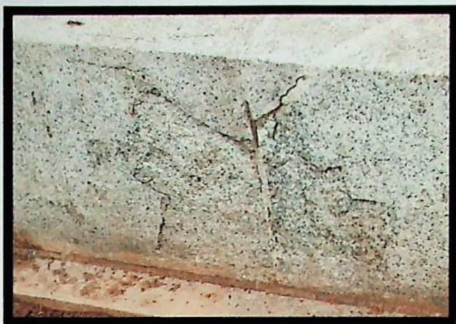
Figura 1. Plaqueta na base: destacam-se fragmentos achatados paralelos à superfície.
