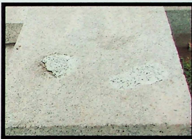
Figura 4. Argamassa usada no preenchimento de lacunas.
