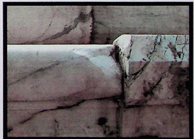
Figura 6. Deslocamento dos blocos de mármore.
