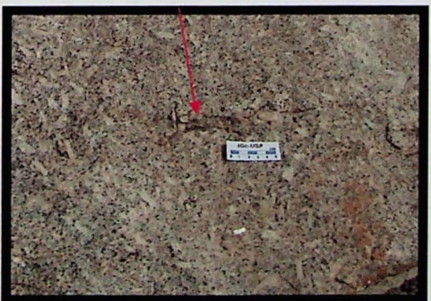
Figura 5. Escamação do granito.
