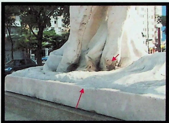
Figura 3. Deposição superficial e lascas no mármore.
