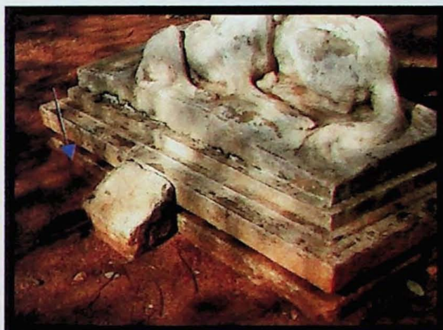
Figura 4. Placa de bronze roubada e descascamento da caiação.
