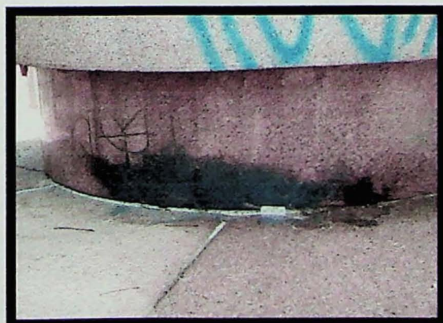
Figura 11. Granito "carbonizado".
