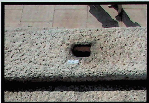
Figura 13. Buracos ao longo do topo usados para fixação de equipamentos durante o deslocamento da obra.
