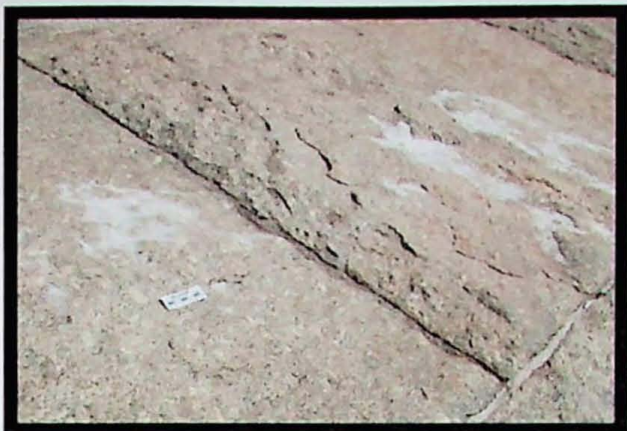
Figura 7. Areia branca consolidada em um bloco de granito na lateral esquerda da obra.
