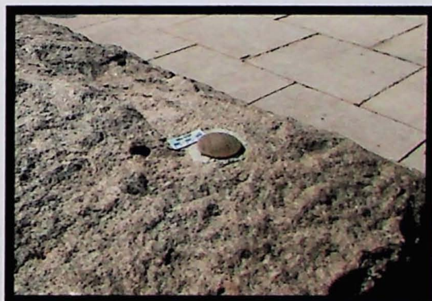
Figura 6. Argamassa usada para fixar um objeto de bronze no monumento.
