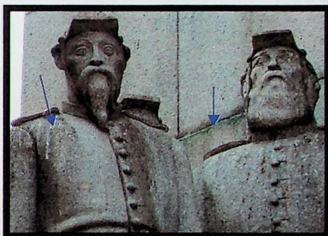
Figura 4. Fezes de pombo. Crosta verde no rejunte.
