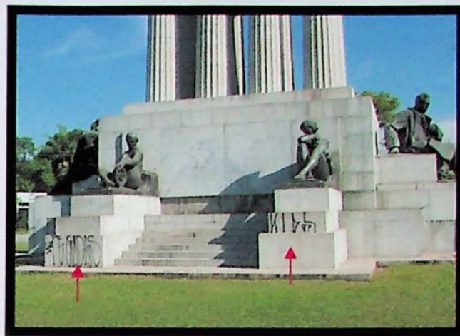
Figura 8. Base pichada com spray preto.
