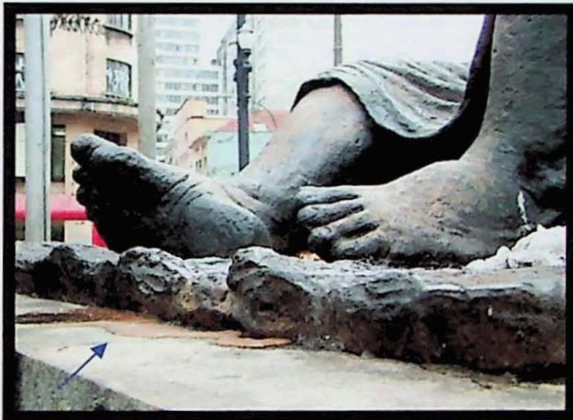
Figura 3. Parafina de vela derretida sob a base de granito.
