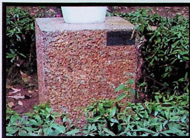
Figura 2. Base de granito em boas condições de conservação.
