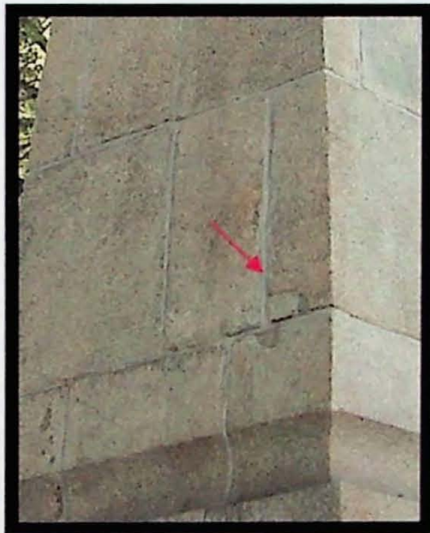
Figura 3. Rejuntas e pequenas depressões preenchidas por argamassa na restauração.
