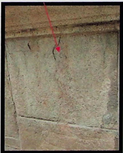
Figura 3. Rejuntas e pequenas depressões preenchidas por argamassa na restauração.
