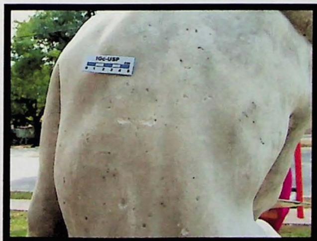
Figura 5. Feições alveolares (intemperismo) e pequenas depressões (depredações).
