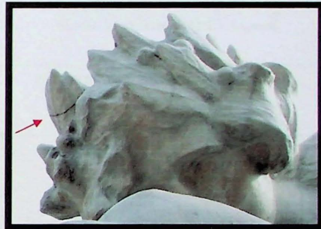
Figura 4. Cabelo colado na restauração.
