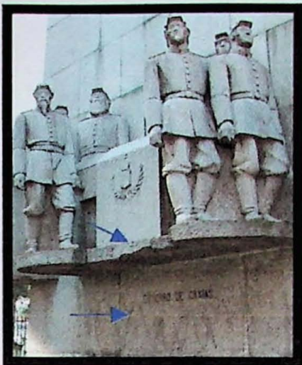
Figura 6. Base pichada com spray e superfície da peça de granito quebrada.
