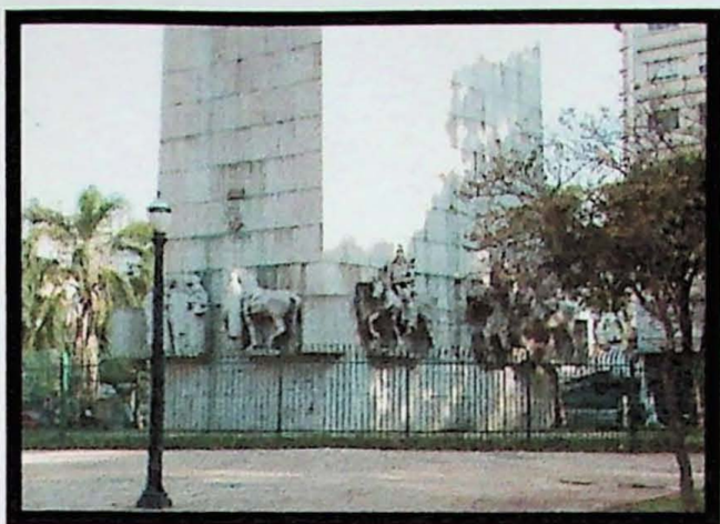
Figura 1. Obra cercada por grade verde.
