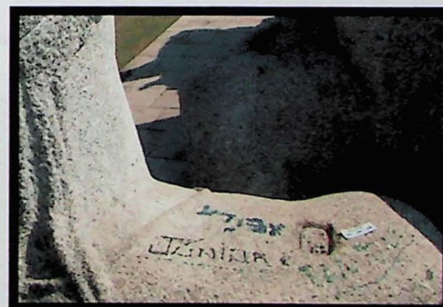
Figura 12. Pichação com tinta no topo do monumento.
