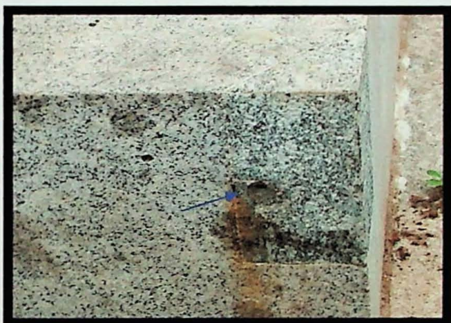
Figura 3. Quina restaurada com granito similar ao original. Notar cano para escoamento da água infiltrada.
