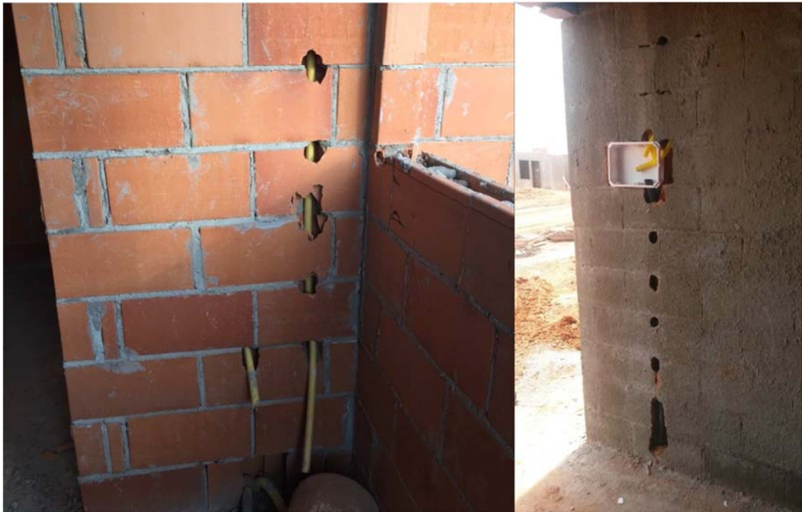
Figura 34: Quebra da alvenaria para passagem de eletroduto em etapa posterior à programada
