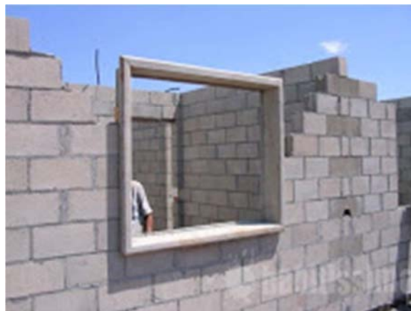
Figura 19: Vergas e contravergas executadas em pré-moldados
