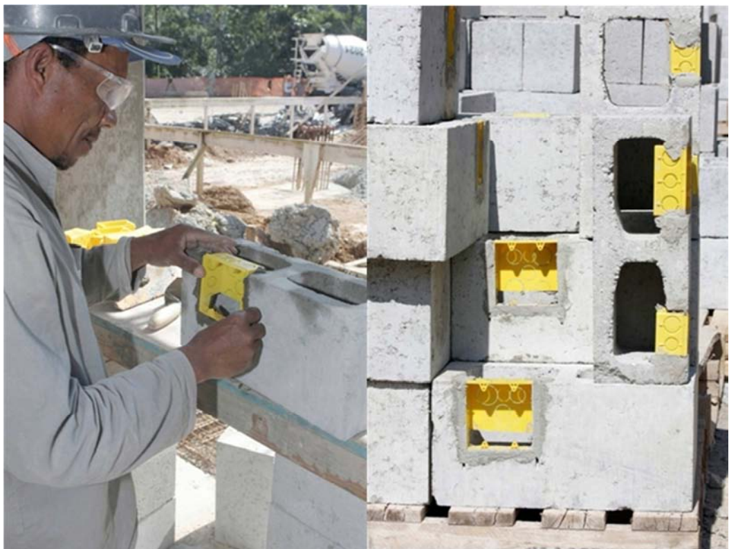
Figura 21: Central de chumbamento de caixas para instalações elétricas e sistemas
