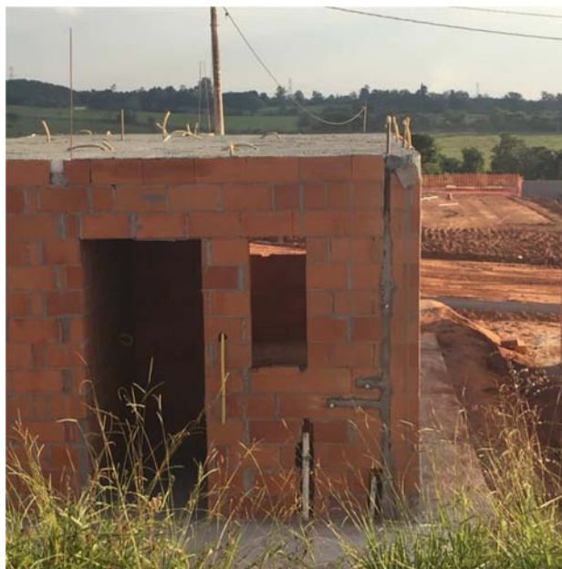
Figura 32: Rasgos para instalações
