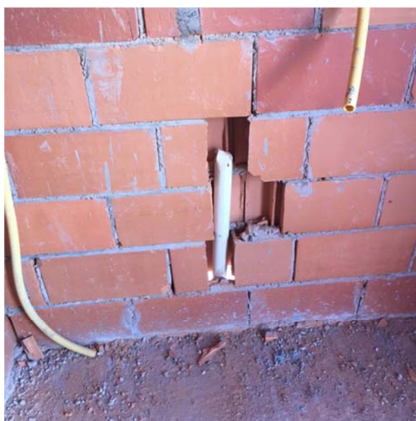
Figura 33: Rasgos para instalações
