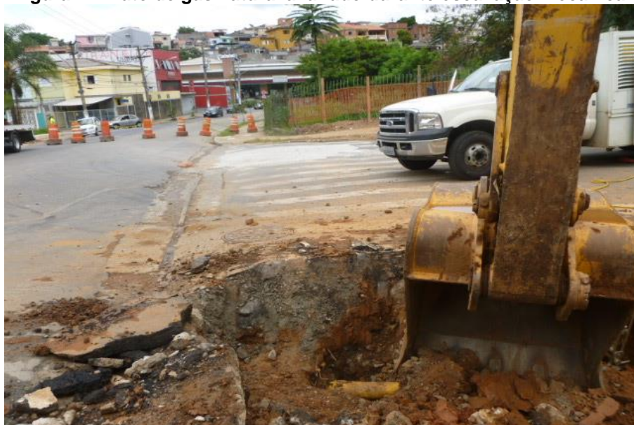
Figura 7 – Duto de gás natural avariado durante escavação mecânica.
