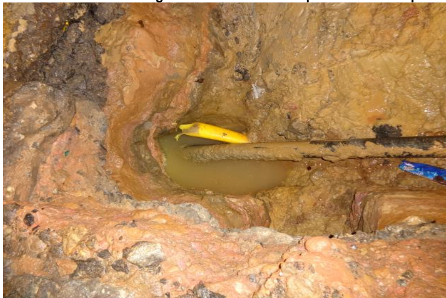
Figura 9 – Avaria em duto de gás natural ocasionado por atividade de perfuração.
