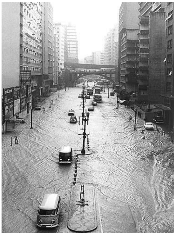
Figura 22 - Inundação da Av. Nove de Julho em 1976 com o escoamento ocupando toda a avenida. Disponível: https://veja.abril.com.br/galeria-fotos/sao-paulo-decadas-de-chuvas . Acesso em: jan. 2024.
