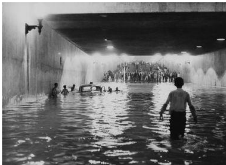
Figura 25 - Inundação no Túnel Anhangabaú (1963). Disponível em: https://veja.abril.com.br/galeria-fotos/sao-paulo-decadas-de-chuvas . Acesso em: jan. 2024.
