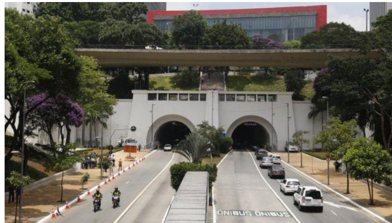
Figura 10 - Túnel Nove de Julho na nascente do Vale Saracura. Disponível em: https://www.bbc.com/portuguese/brasil-44760577 . Acesso em: jan. 2024.
