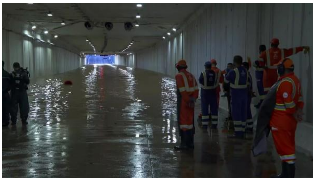
Figura 27 - Inundação do Túnel Anhangabaú (2021). Disponível em: https://g1.globo.com/google/amp/sp/noticia/2021/01/01/chuva-forte-causa-alagamento-na-regiao-do-vale-do-anhangabau.ghtml . Acesso em: jan. 2024.
