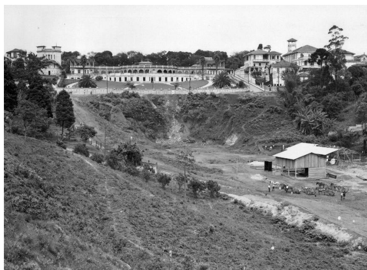
Figura 8 - Nascente do Vale do Saracura, área onde foi construído o Túnel Nove de Julho. Disponível em: https://ieccmemorias.wordpress.com/2015/06/15/no-acervo-do-estadao/ . Acesso em: jan. 2024.
