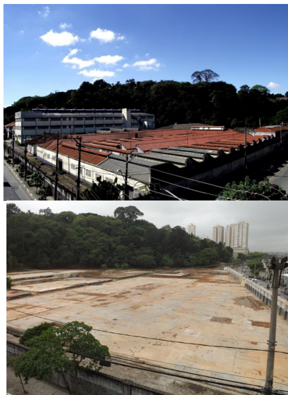
Imagem 23 e 24: Fábrica de Pianos Fritz Dobbert. Atualmente foi realocada em Osasco e no terreno serão construídas torres residenciais. Fonte: disponível em http://www.pirituba.net/fritzdobbert/
