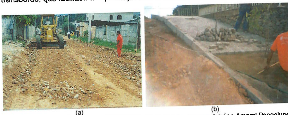
Figura 6.1: (a) Utilização do agregado reciclado como sub-base na rua Adelina Amaral Pongelupe, em Belo Horizonte/MG. (b) Calçamento da usina da Pampulha sendo realizado com bloquete reciclado produzido pela própria usina (2003). Fonte: MIRANDA (2005).
