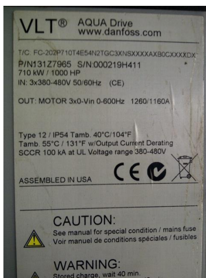
Figura 27 - Conversor de Freqüência: Modelo VLT FC 202 - 1000HP – 440 VAC – 1160 A.
