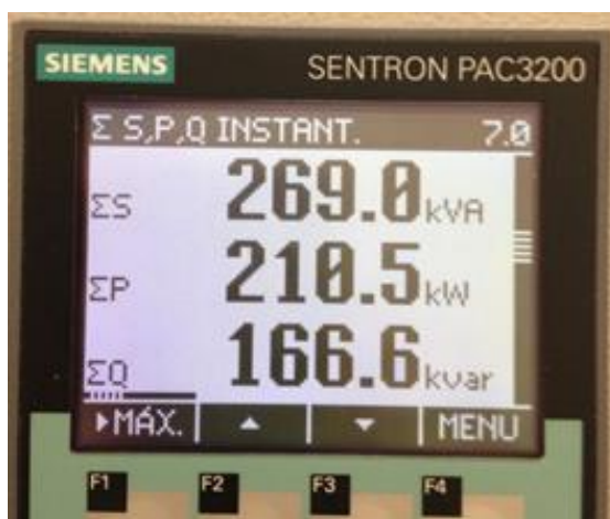
Figura 39 – Multimedidor com indicação da potência consumida pelo sistema.
