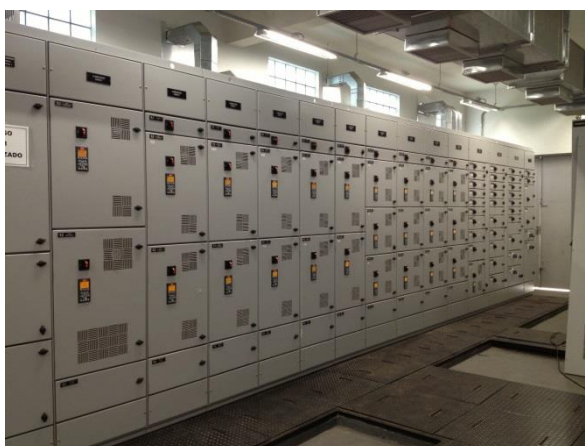
Figura 37 – Foto do Painel do CCM
