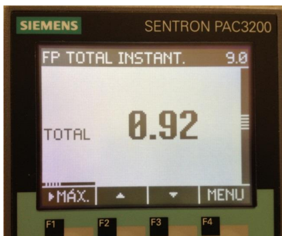
Figura 49 – Multimedidor com a indicação do fator de potência em 0,92.
