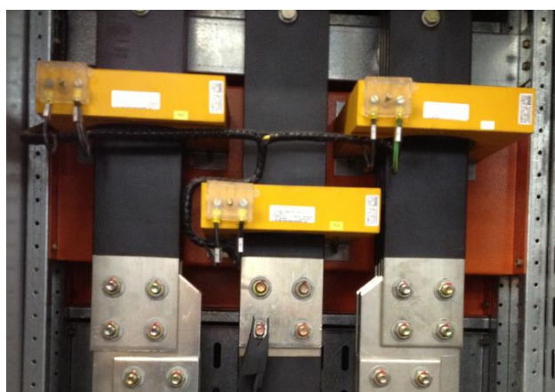
Figura 41 – Barramentos de alimentação de motores e acionamentos.
