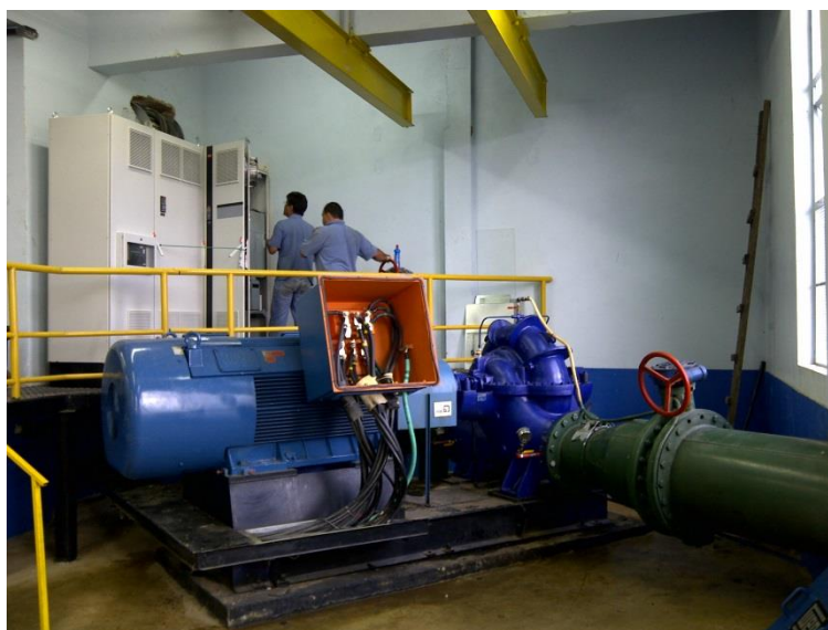
Figura 27 - Conversor de Freqüência: Modelo VLT FC 202 - 1000HP – 440 VAC – 1160 A.
