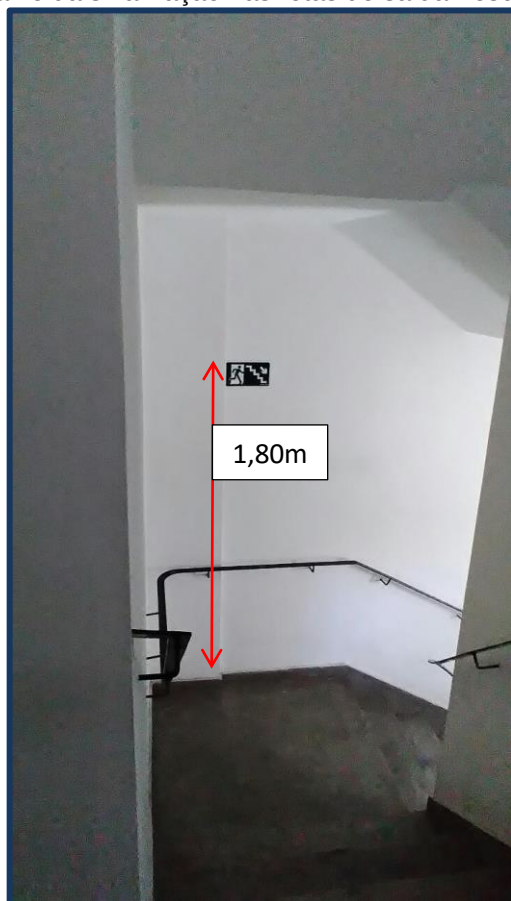
Figura 28 – Detalhe da sinalização nas rotas de saída - escadas.
