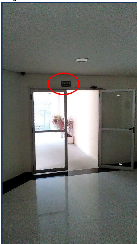
Figura 29 – Detalhe da sinalização do andar de descarga.
