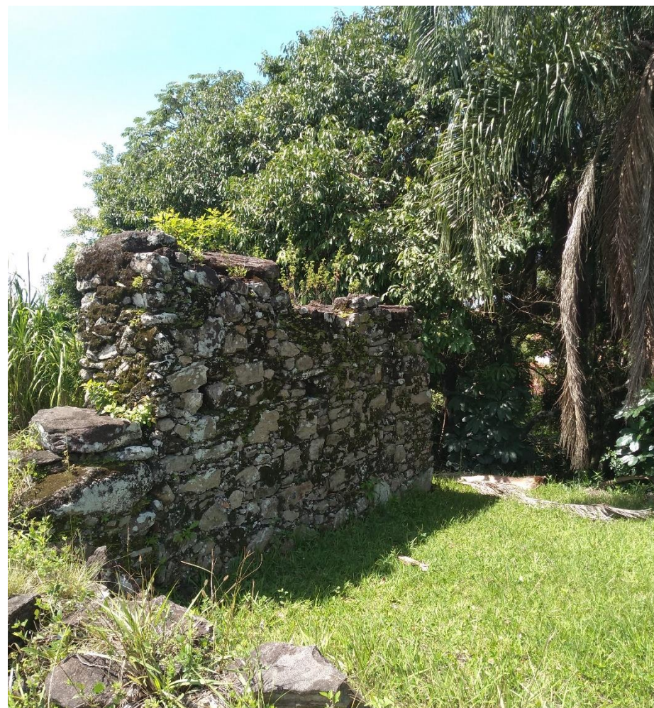
Figura 7 - Vista de uma das paredes das ruínas. Autoria: Mônica Bertoldi André.
