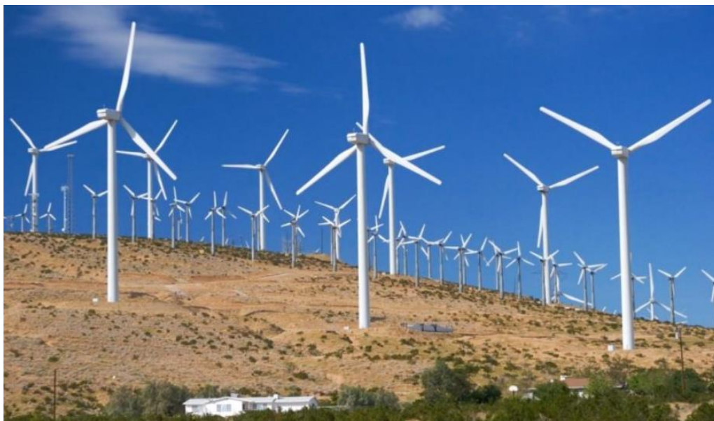
Figura 38 – Parque Eólico no Rio Grande do Norte
