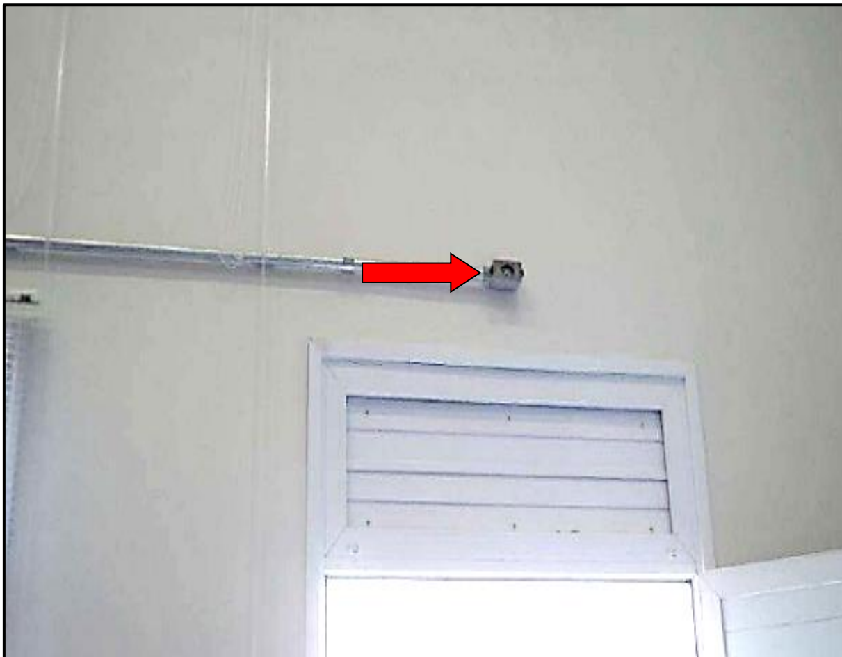
Figura 17 – Ausência de luminárias de emergência
