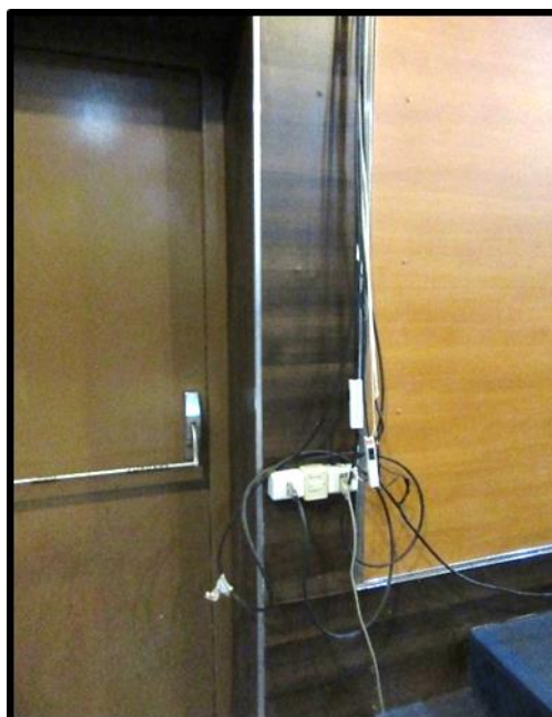
Figura 25 – Circuitos expostos por falta de eletroduto
