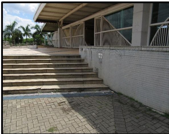
Figura 32 – Falta corrimão intermediário e na parede do lado direito
