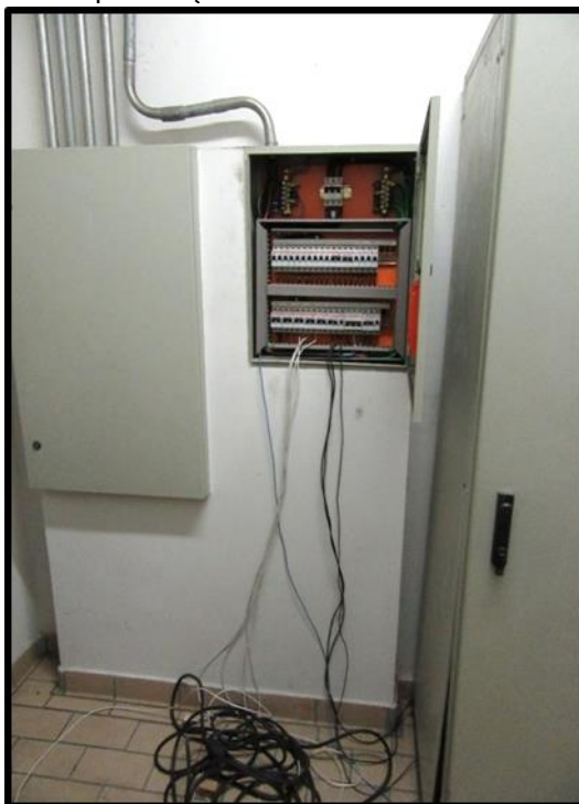
Figura 23 – Quadro elétrico sem sinalização e com improvisações
