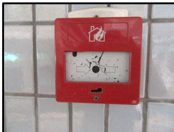
Figura 34 – Botoeira danificada
