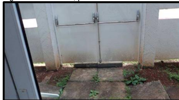
Figura 27 – Saída 2, piso externo desnivelado
