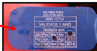
Figura 15 – Magueira Validade teste Hidrostático
