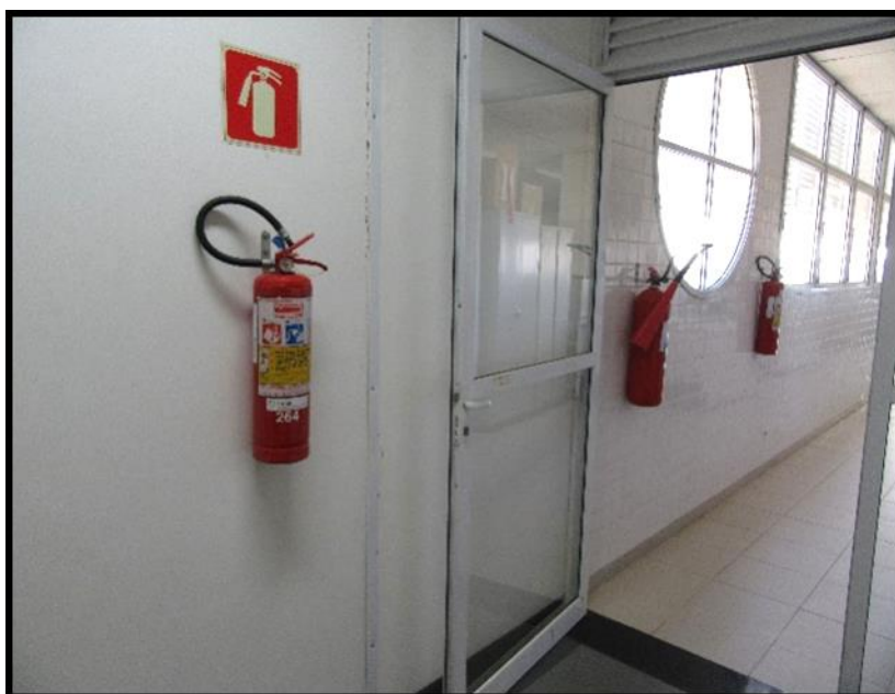
Figura 11 – Extintores instalados sem observar distanciamento de grau de risco
