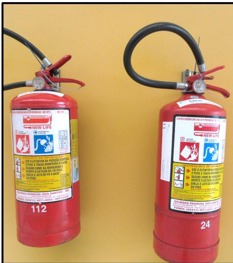
Figura 12 – Edifício com extintores somente classe BC
