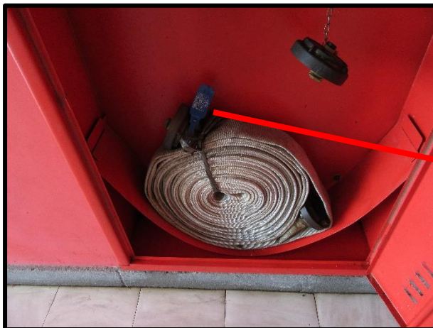
Figura 14 – Caixa de hidrante
