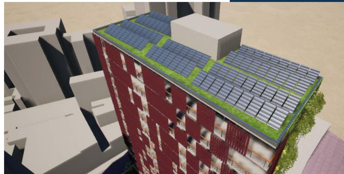
Figura 134: Cobertura da Torre 1 | Painéis fotovoltaicos.
