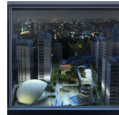
Figura 60: Vista externa do Edifício Praça Pamplona. Foto: Daniel Ducci
