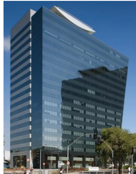
Figura 19: Torre do Complexo Rochaverá. Foto: Nelson Kon
