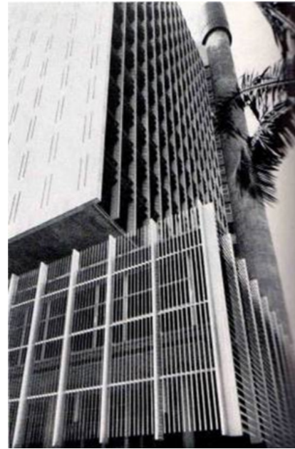
Figura 51: Destaque dos brise-soleils . Fonte: Revista Acrópole
