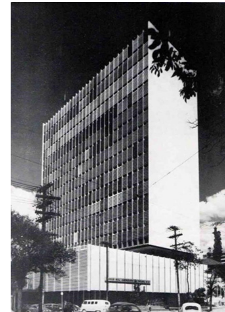
Figura 49: Imagem geral do edifício em 1966. Foto: Revista Acrópole
