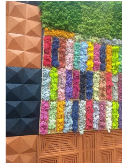
Figura 43: Exemplos de materiais de revestimento com absorção acústica. 1 ST FLOOR - ExpoRevestir. Foto: Beatriz Nascimento, 2020
