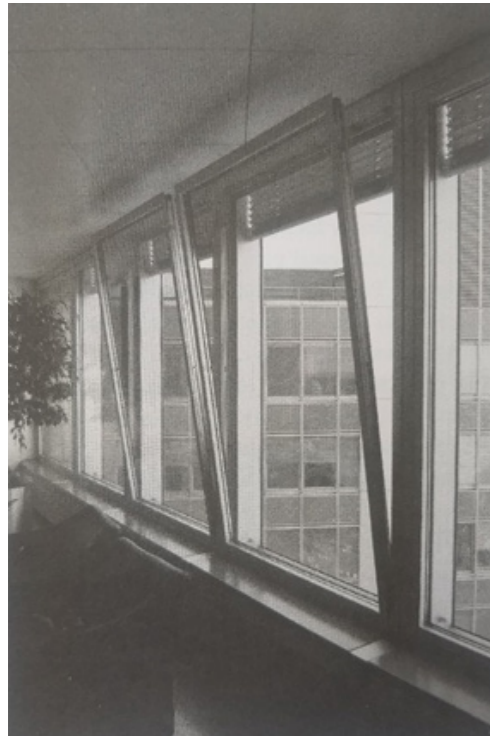
◀ Figura 39: Janelas do Commerzbank, em Frankfurt, uso de sombreamento sem interferência Foto: Joana Gonçalves
