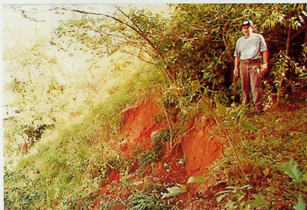
Foto 8 – Ruptura consolidada (Rio Comprido)
