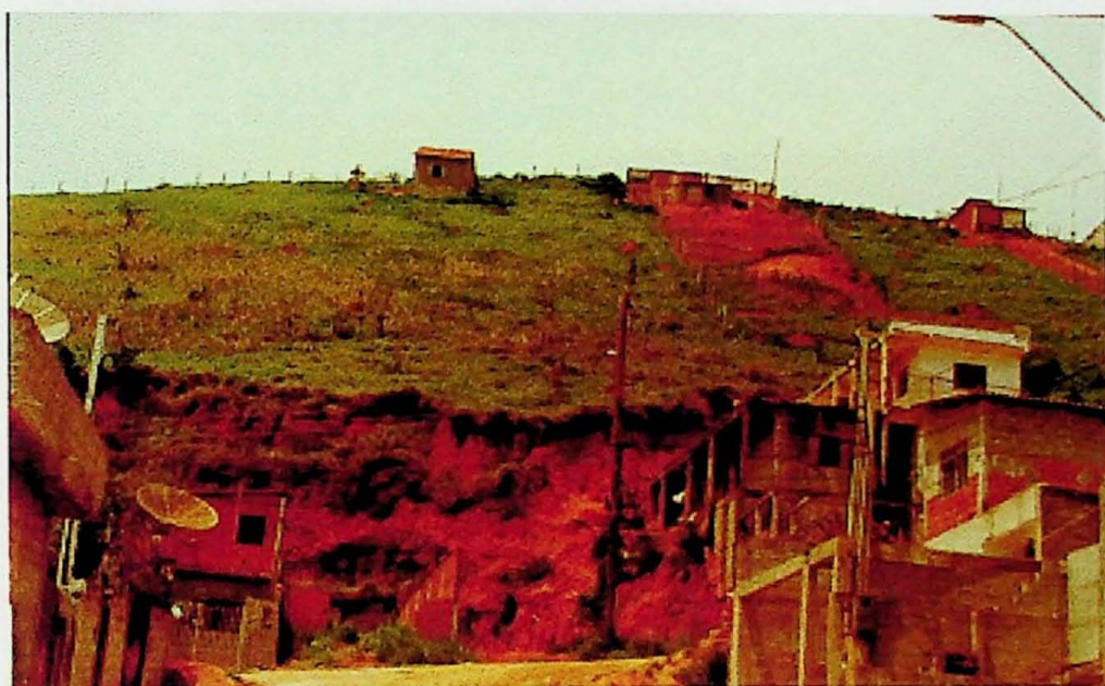
Foto 18 – Aterros lançados no alto e corte irregular na base da encosta (Mirantes do Buquirinha)
