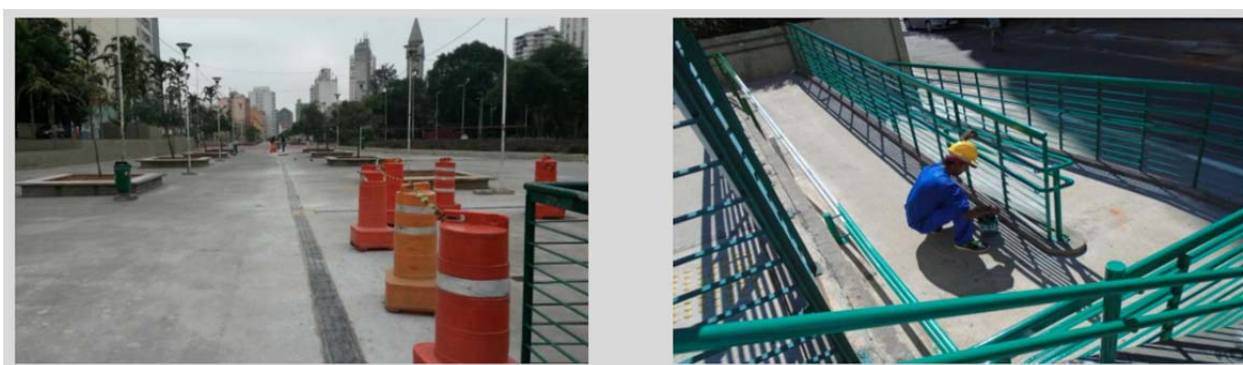
Figura 51 – Piso tátil direcional e substituição de corrimãos em execução.
