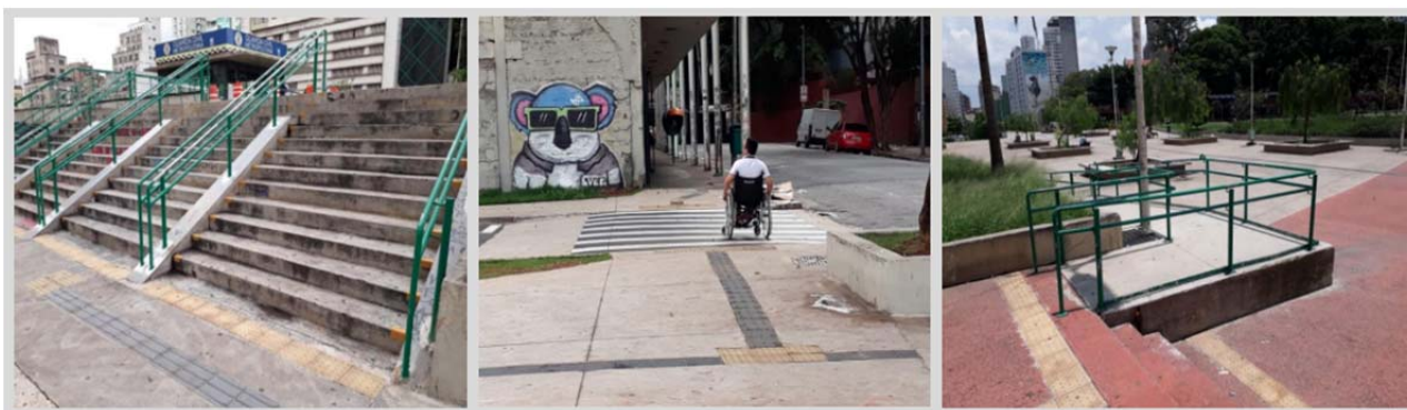
Figura 52 – Substituição de corrimãos, faixa de travessia elevada e rampa de acessibilidade executados.
