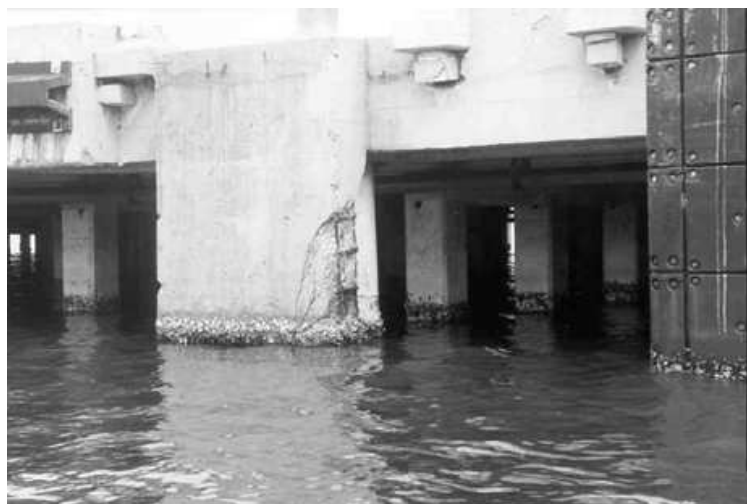
Figura 1. Corrosão por cloretos do pilar. (notas de aula- Helene, 2009)
