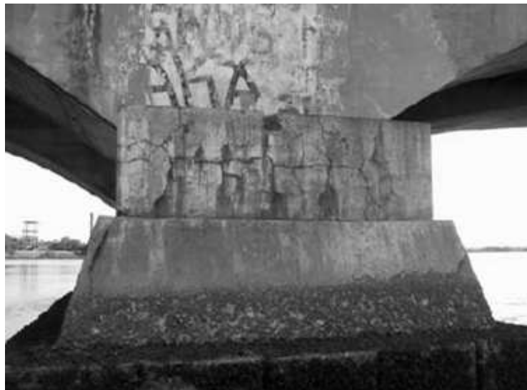
Figura 5. Pilar de uma ponte com ELU comprometido pela RAA. (SANCHEZ apud HELENE, 2002)
