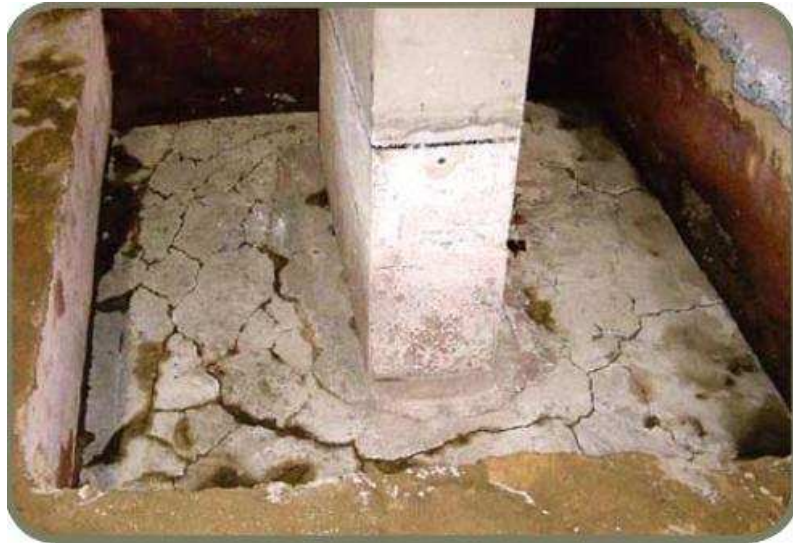
Figura 4. Blocos de fundação com fissuras em mapa causadas pela RAA. (FIGUERÔA; ANDRADE, 2007)
