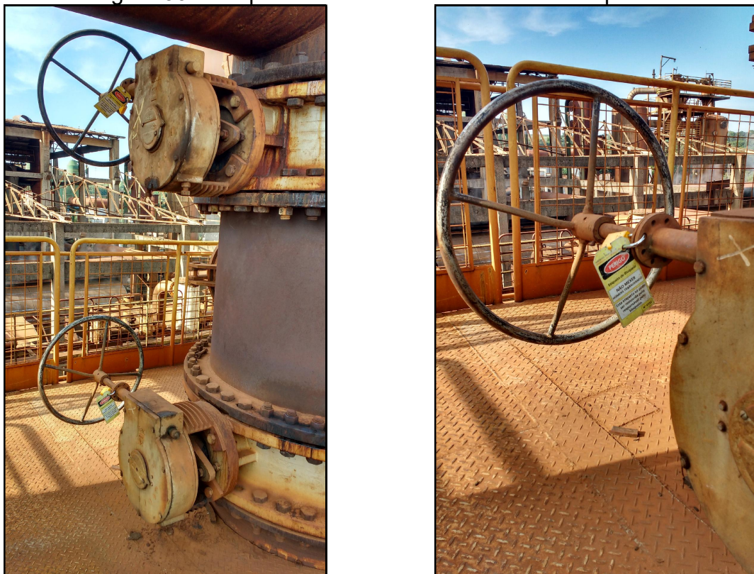
Figura 30 - Bloqueio das válvulas de entrada do vapor
