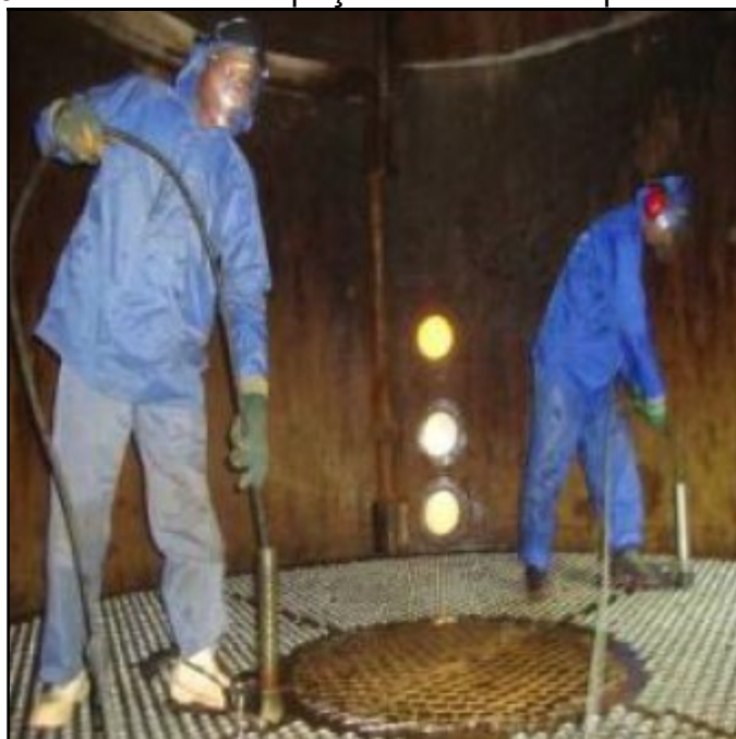
Figura 9 - Trabalho em espaço confinado: evaporador de caldo
