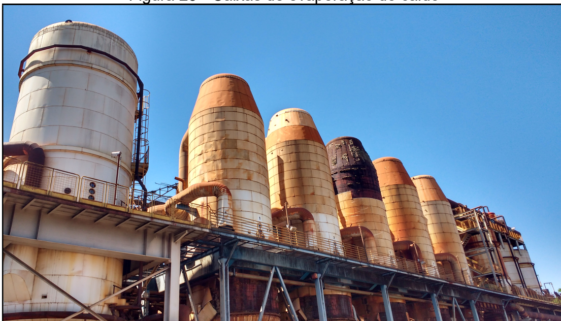
Figura 25 - Caixas de evaporação do caldo
